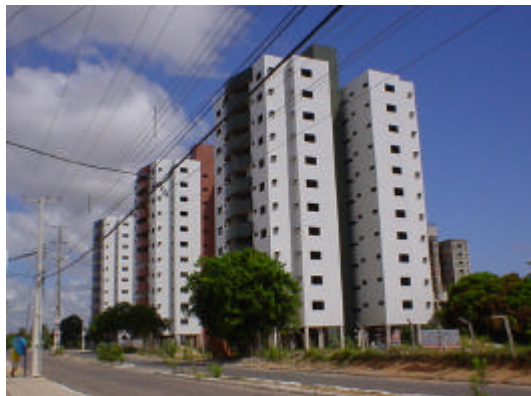
a) Vista dos blocos de apartamentos – obra inacabada
