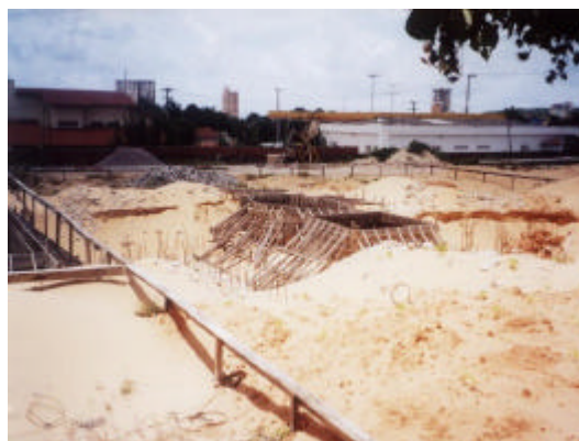
d) Local do edifício – obra paralisada
