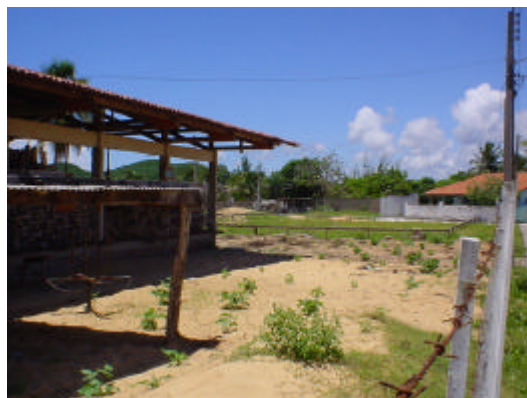
d) Canteiro de obras e área destinada para lazer
