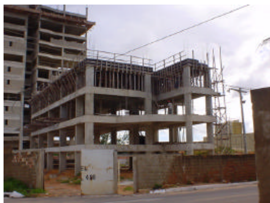
c) Unidade Habitacional – obra paralisada
