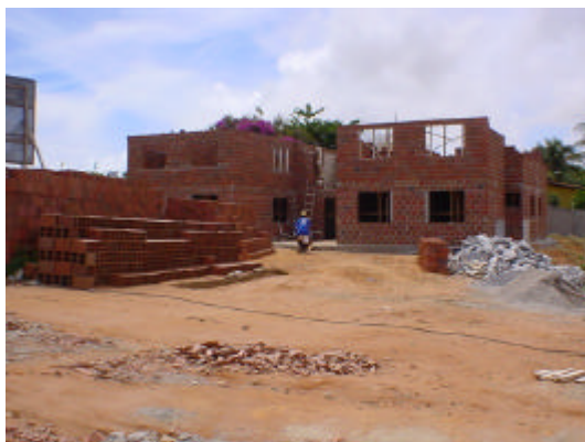
e) Blocos de apartamentos em obra
