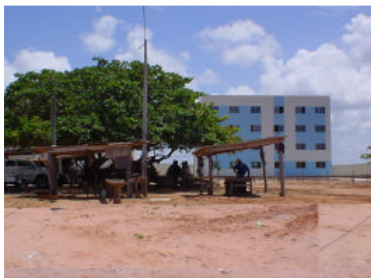
c) Canteiro de obras e bloco de apartamentos
