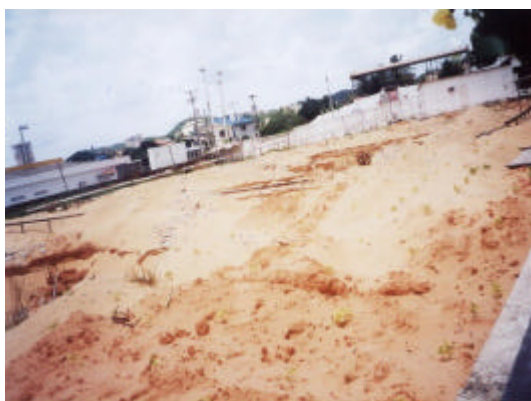
c) Local do edifício – obra paralisada
