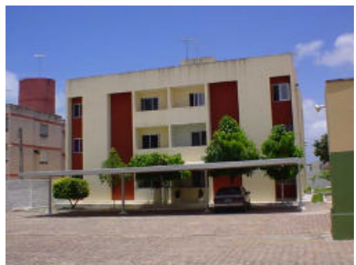
FIGURA 3 - Torre do Sul Crédito: Adriana Castro Fonte: Pesquisa de Campo
