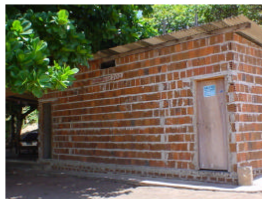
d) Canteiro de obras
