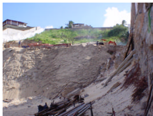
d) Local do empreendimento – obra em andamento
