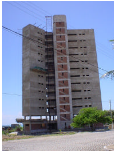
d) Torre de apartamentos – vista posterior
