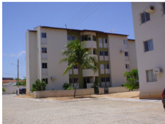
b) Unidade habitacional – vista frontal
