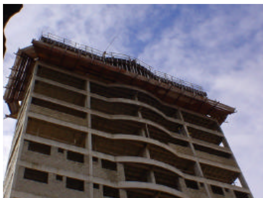
e) Vista parcial da obra
