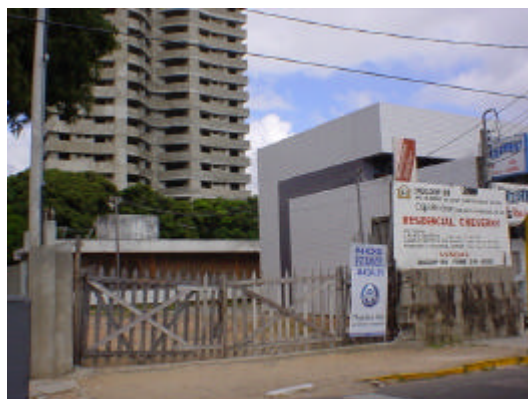
b) Entrada do condomínio
