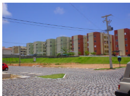
d) Blocos de apartamentos em "condomínio", sem pilotis e elevador
