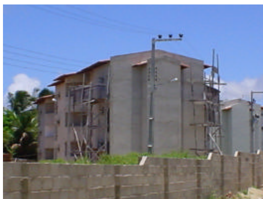
c) Unidade habitacional em construção
