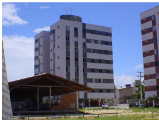
b) Blocos de apartamentos e canteiro de obras
