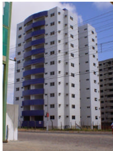
b) Bloco em fase de construção
