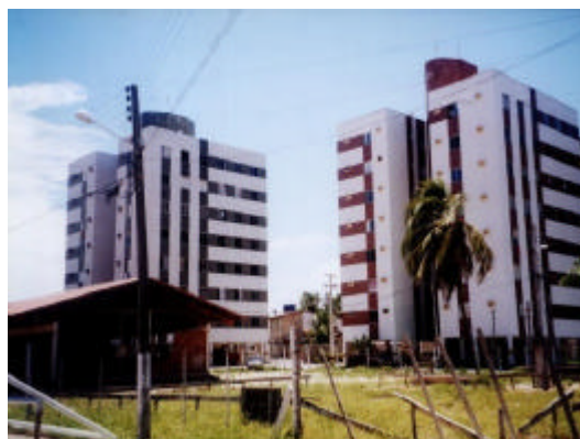
e) Conjunto de blocos do condomínio
