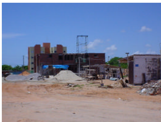
c) Bloco de apartamentos em construção
