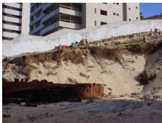
c) Local do empreendimento – obra em andamento
