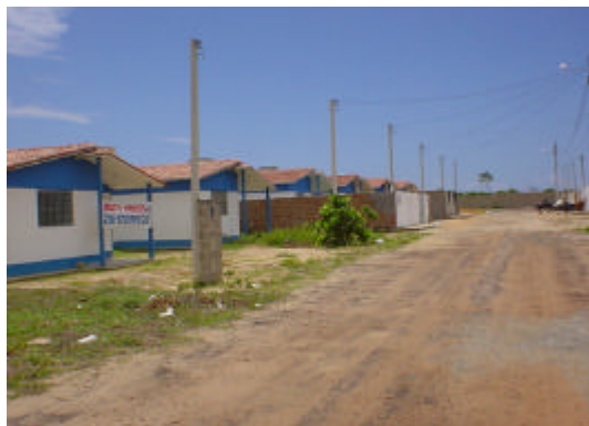
a) Casas em condomínio
