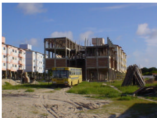
c) Blocos de apartamentos em construção
