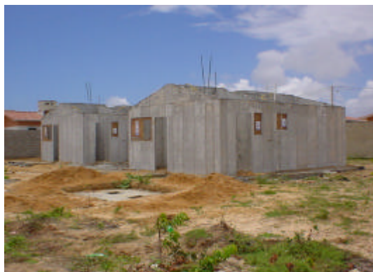
c) Unidade habitacional em construção
