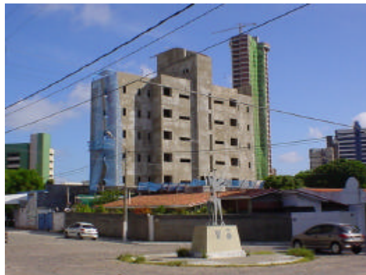
b) Bloco de apartamento em construção
