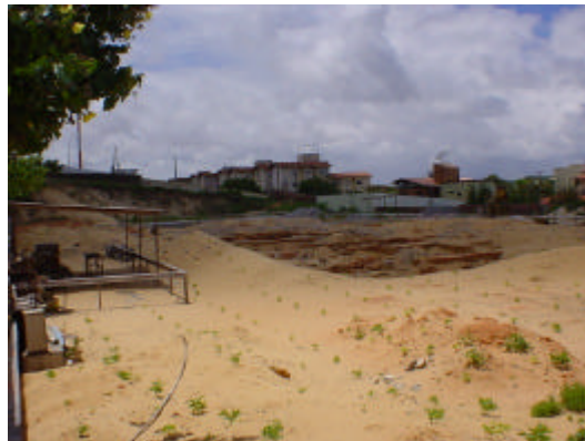
b) Local do edifício – obra paralisada
