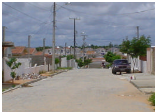
a) Vista parcial do conjunto
