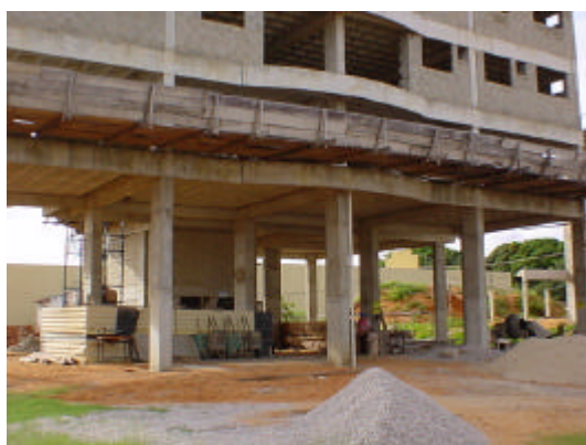
c) Pavimento térreo/ garagem
