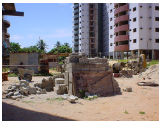
d) Canteiro de obras
