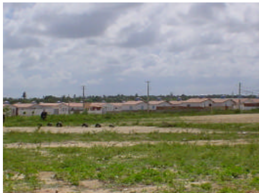
a) Vista parcial do conjunto
