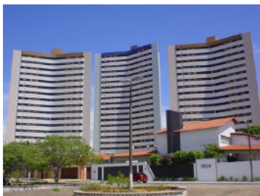
c) Vista frontal das três torres de apartamentos
