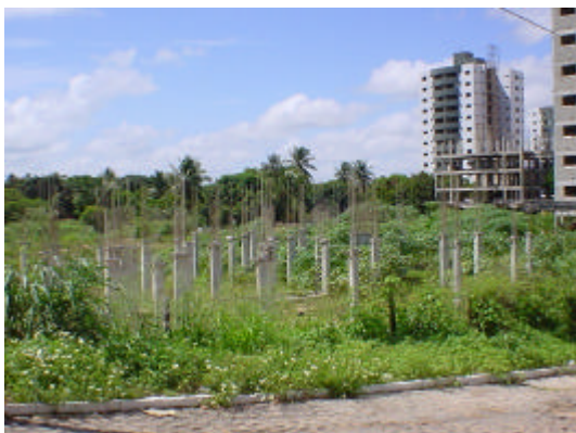
e) Fundação de um dos blocos
