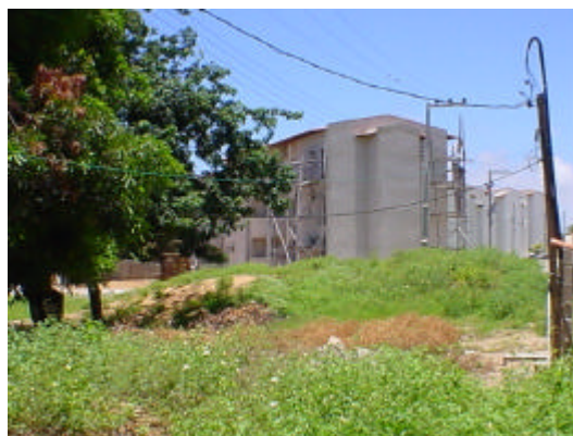
f) Área livre no terreno do condomínio
