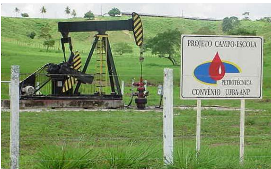
Figura 4.2. Poço de Quiambina 04-A
