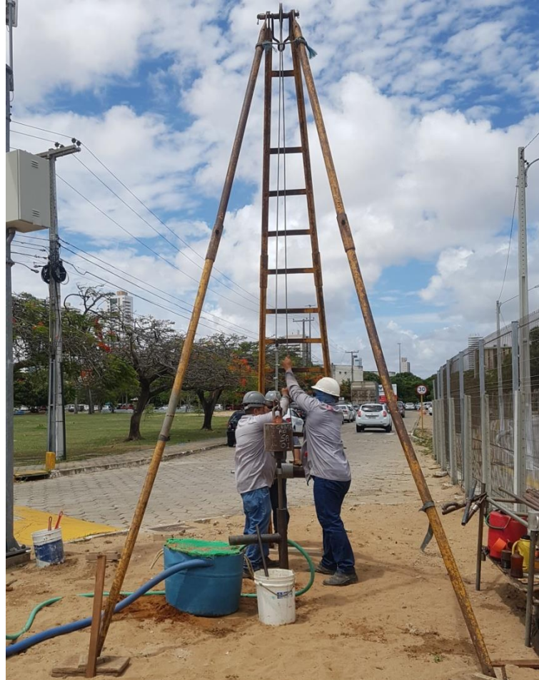
Figura 3.4 – Execução do ensaio SA-01.
