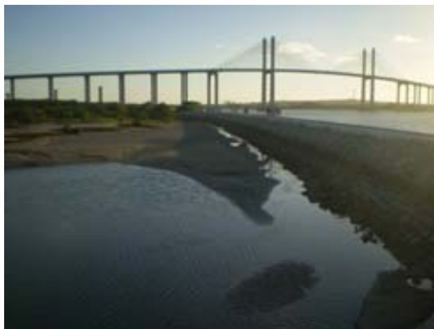
Foto 12. Ponte Nilton Navarro. Praia do Forte-Redinha. Natal-RN
