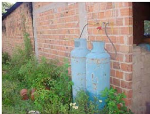
Figura 79: Detalhe do botijão do forno a gás Fonte: SANTOS, 2008
