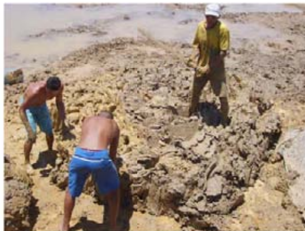
Figura 32: Aprontador pisando e aguando o barro Fonte: Arquivo pessoal, 2009
