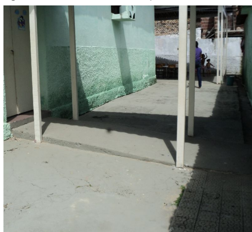
Fotografia 4 – Área de circulação interna do CMEI 3
