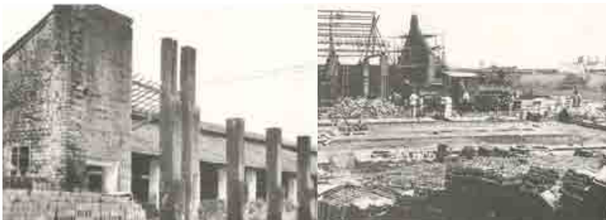
Figura 5 Ruínas da Cerâmica São João
