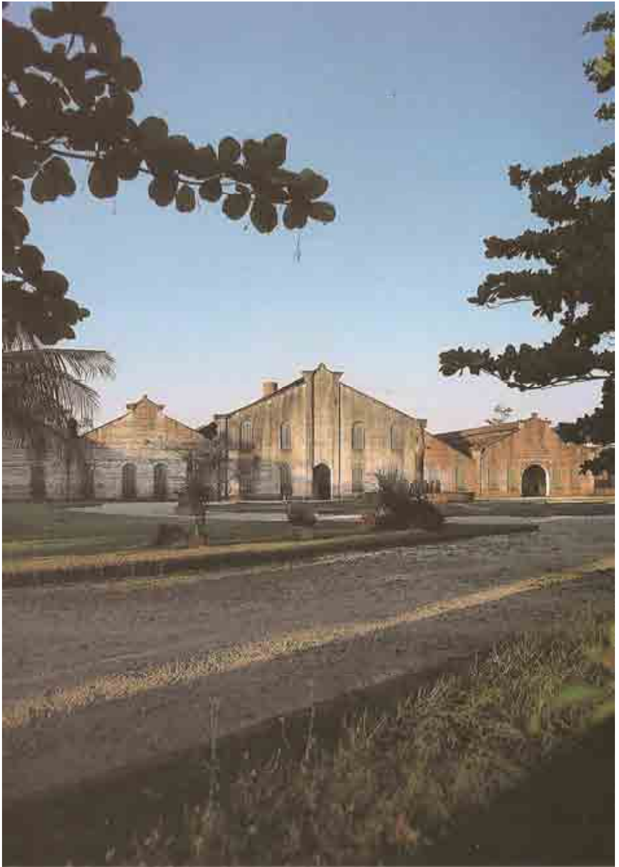
Figura 1 Vista ao longe dos Galpões do Museu Oficina Cerâmica Francisco Brennand
