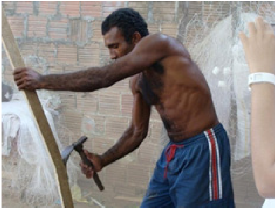
Figura 43: Desbaste das cavernas para adequá-las à estrutura da embarcação.
