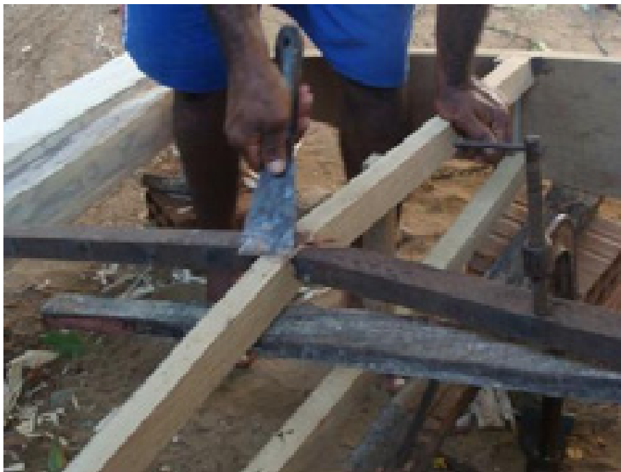
Figura 48: Regulação feita pelo carpinteiro passando cola no local danificado. Fonte: Acervo do Projeto Jangadeiros (GREPE/UFRN)
