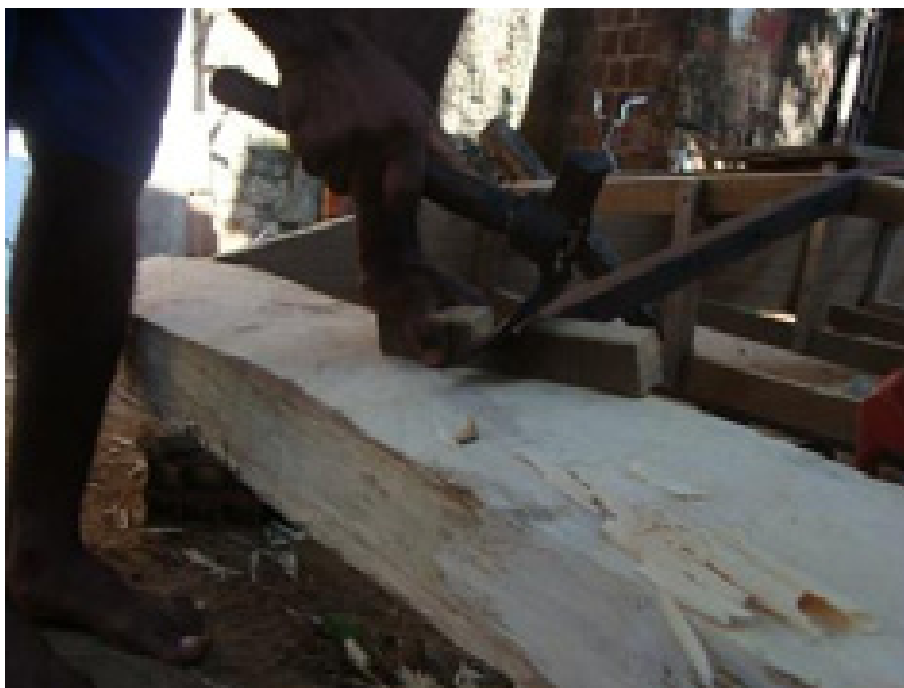
Figura 49: Carpinteiro confeccionando peça para dar maior sustentação à parte danificada. Fonte: Acervo do Projeto Jangadeiros (GREPE/UFRN)
