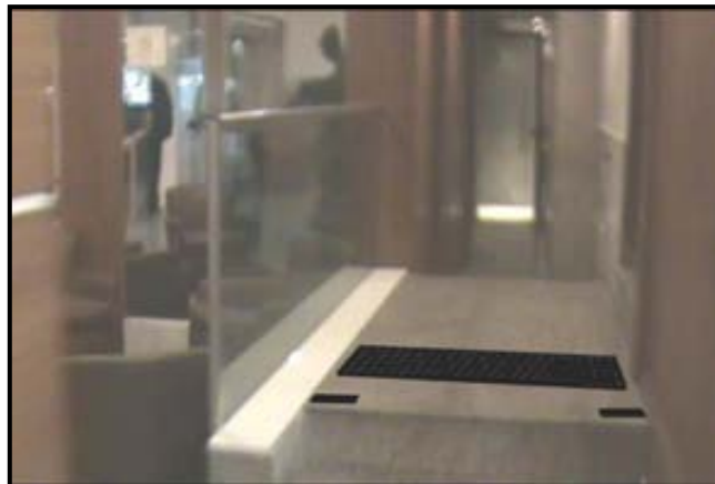
Figura 14 - Recomendação do piso tátil de alerta e sinalização visual nos degraus.
