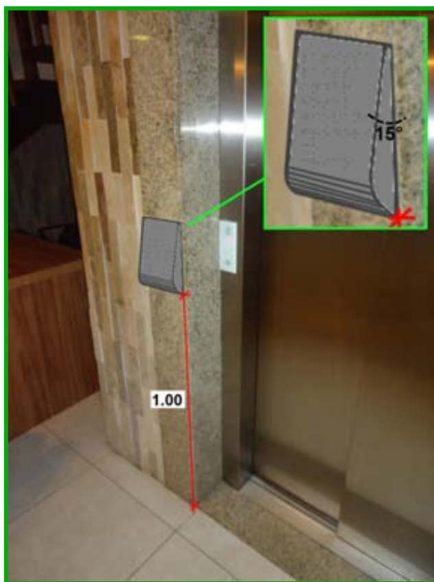
Figura 78 - Proposta de informativo em Braille próximo a botoeira do elevador.
