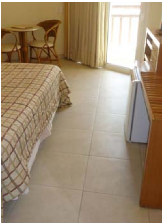
Figura 28 - Revestimento do piso antiderrapante, contínuo, sem ressaltos ou depressões.
