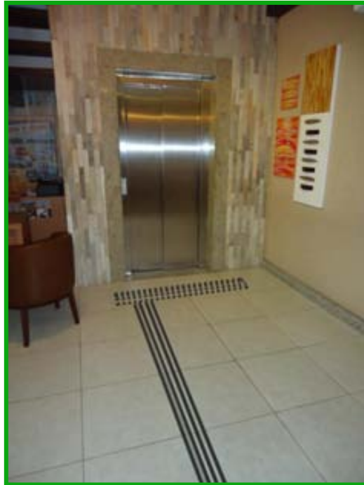
Figura 80 - Piso tátil direcional levando ao piso tátil de alerta próximo ao elevador.
