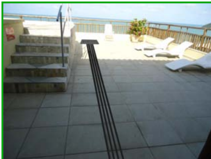
Figura 91 - Piso tátil direcional na área do mirante.
