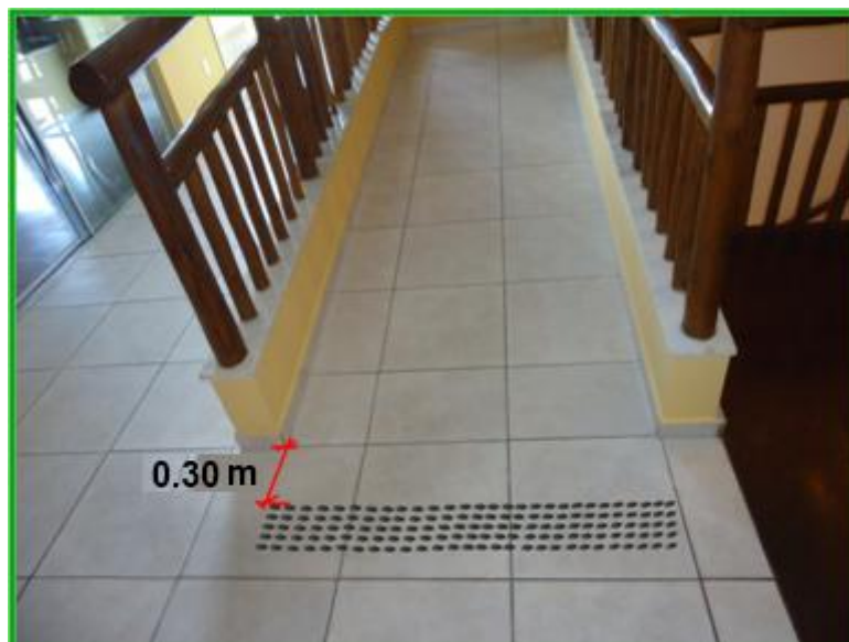
Figura 82 - Proposta de piso tátil de alerta antes da rampa.
