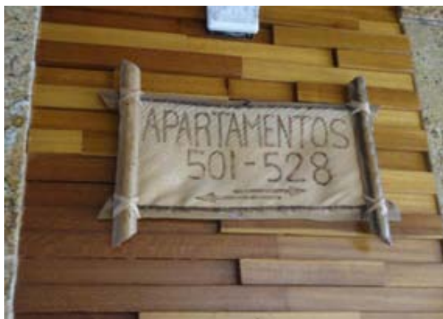
Figura 30- Sinalização dos apartamentos sem fonte ou cor contrastante com a do fundo.
