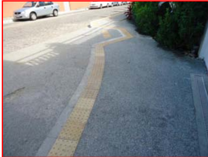
Figura 72 - Calçada do hotel com piso tátil de alerta.
