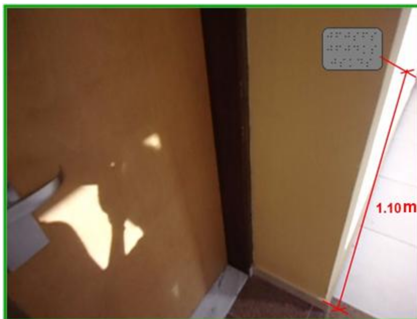
Figura 86 - Proposta de informação em Braille no batente da porta.
