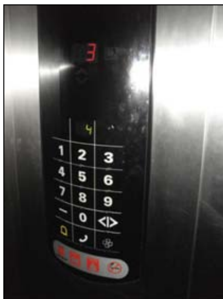
Figura 29 - Painel interno do elevador de um dos hotéis da pesquisa – botões sensíveis ao toque.
