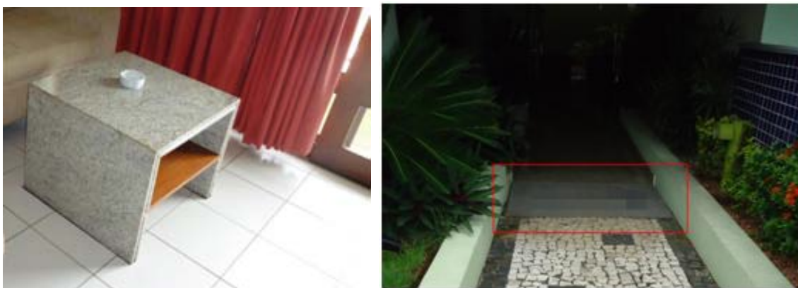
Figura 26 - Móvel com quinas vivas e capacho não embutido no piso.
