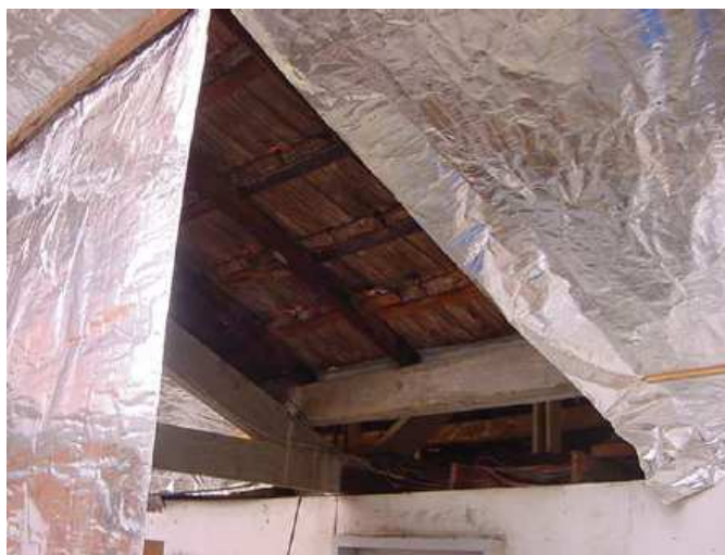
Figura 2.2. Vista da barreira radiante e o telhado.
