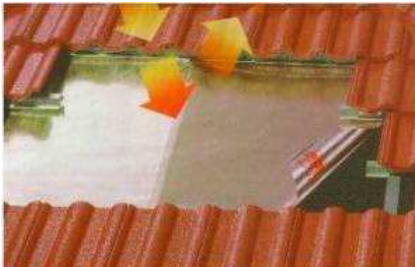
Figura 2.3. Barreira de radiação térmica de alumínio. Fonte: ARMELIN (2004).
