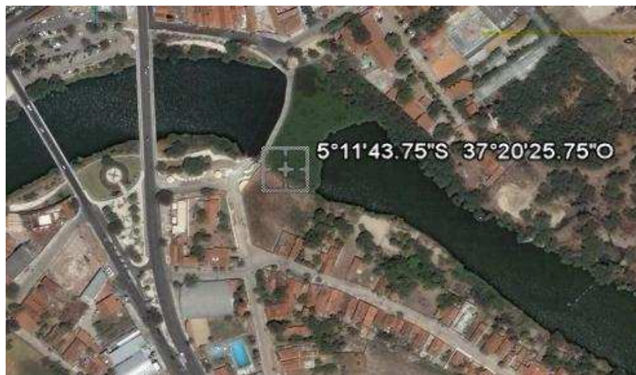
Figura 4 - Ponto 2 e sua respectiva coordenada geográfica, localizado no leito principal do Rio Apodi/Mossoró no centro de Mossoró, RN.
