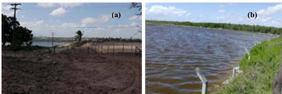
Figura 2.2 – (a) empreendimento de carcinicultura localizado entre as comunidades de Uruaçu de Baixo e Pajuçara em São Gonçalo do Amarante. FONTE: IDEMA, 2004; (b) empreendimento de carcinicultura localizado nas proximidades da comunidade Beira Rio, na cidade do Natal/RN. Fonte: CORREA, Tatiana, 2007.
