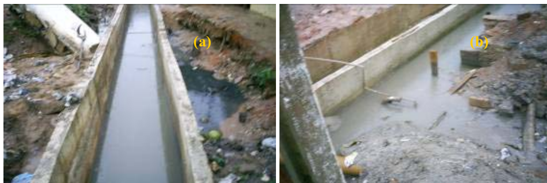
Figura 2.0 (a) vista da vala de dejetos a céu aberto na comunidade Passo da Pátria; (b) vista dos esgotos a céu aberto na comunidade Passo da Pátria durante as obras de urbanização – Cidade Alta.
