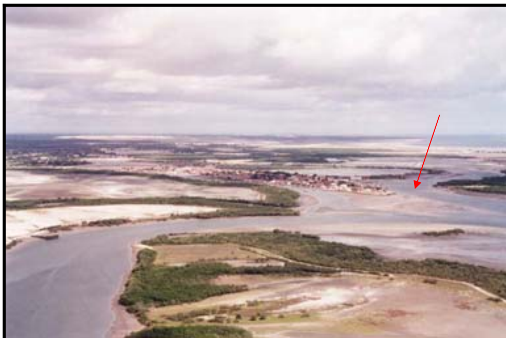
FIGURA 3.14- Aspecto de barras arenosas na parte frontal do canal de acessos de Guararé (Silveira/setembro/2001).
