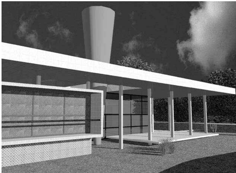
Figura 24 – Casa José Cordeiro Castro. Detalhe da laje dupla. Fonte: 3D de Tota Maia.
