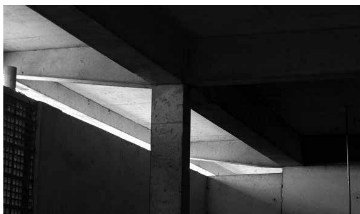
Figura 21 – AGTEC. Cruzeta no topo do pilar. Fonte: Acervo dos autores.
