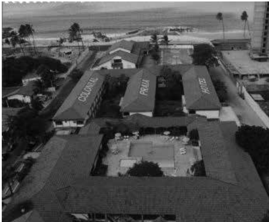
Figura 8 – Vista da cobertura do Hotel Colonial.
