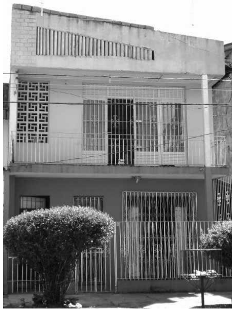
Figura 27 – Residência moderna em uso e bom estado de conservação. Foto: Renata Gribel, 2011.
