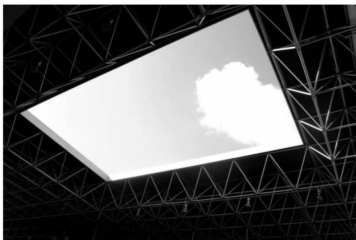
Figura 32 – Bombril-NE. Abertura da cobertura que liga dois blocos. Fonte: acervo dos autores. Foto: Fernanda Mafra.
