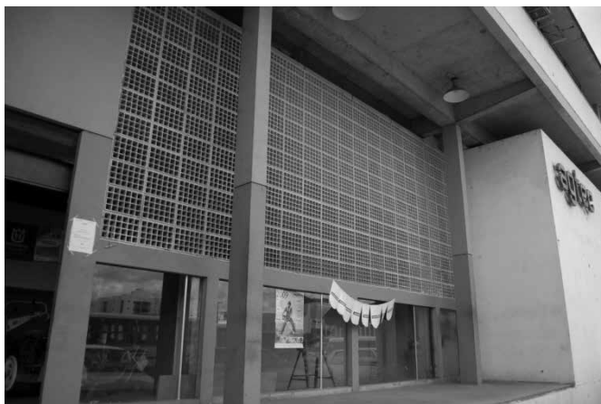
Figura 20 – AGTEC. Fachada oeste. Fonte: acervo dos autores.
