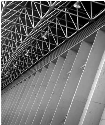
Figura 25 – Fábrica da Bombril-NE, o sistema de vedação e trecho da cobertura em treliça espacial. Fonte: Acervo dos autores. Foto: Fernanda Mafra.
