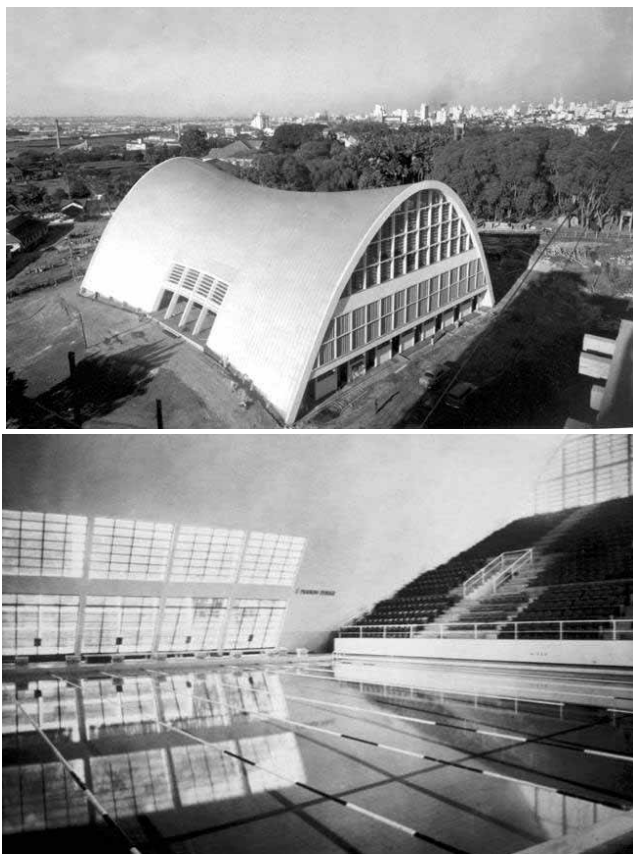
Figura 8 – Ícaro de Castro Mello, Piscina Coberta de Água Branca, 1948, São Paulo. Fonte: Mindlin, 1956, p. 177.
