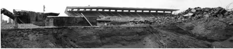
Figura 1 – O Machadão (Natal-RN) nos últimos estágios de sua demolição. Fonte: José Clewton do Nascimento, maio de 2011.
