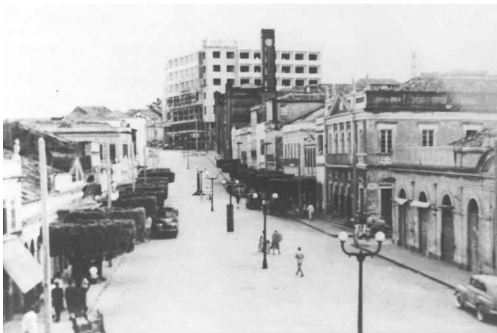
Figura 20 – O Hotel São Francisco em construção em 1961. Fonte: Acervo Família Peixoto.
