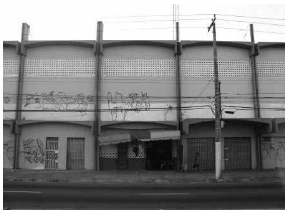
Figura 21 – Muro com cobogó que circunda o estádio Leônidas Castro (“Curuzu”). Foto: Renata Gribel, 2011.
