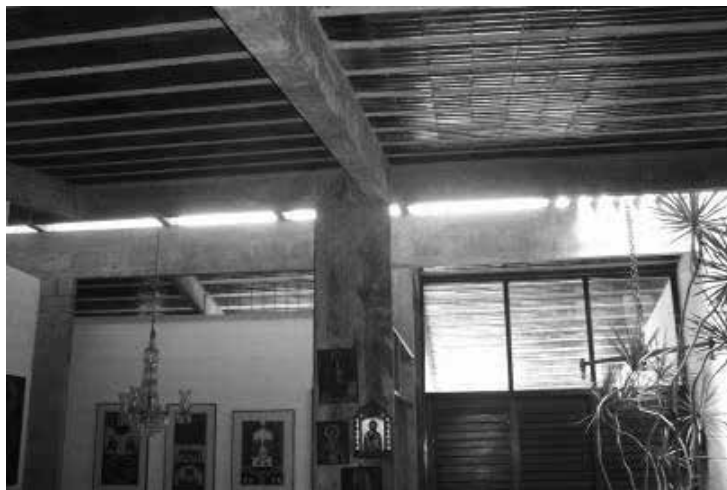
Figura 28 – Vigas em concreto aparente e lajotas cerâmicas aparentes. Visão do shed .
