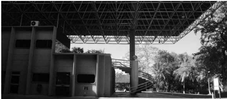
Figura 31 – Bombril-NE. Trecho da cobertura que liga dois blocos e marca o seu acesso, funcionando como um pórtico.
