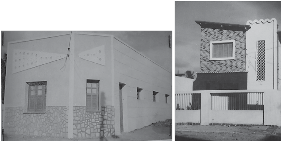
Figura 7 – Casas nas ruas Manoel Elpídio da Silva, Alecrim (1), e Cônego Leão Fernandes, Tirol (2). Adquiridas recém-construídas por financiamento em 1961 e 1960, respectivamente. Fonte: Acervo HCUrb.
