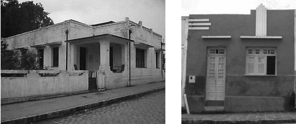
Figura 4 – Residências com elementos do repertório protomodernista (detalhes decorativos nas platibandas, pestanas sobre vãos, marquise plana no terraço). Fonte: Acervo Inventário..., 2011.
