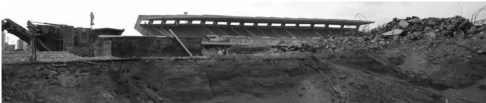
Figura 4 – Estádio Machado. Estágio do processo de demolição, no final de novembro de 2011. Fonte: Acervo do autor.
