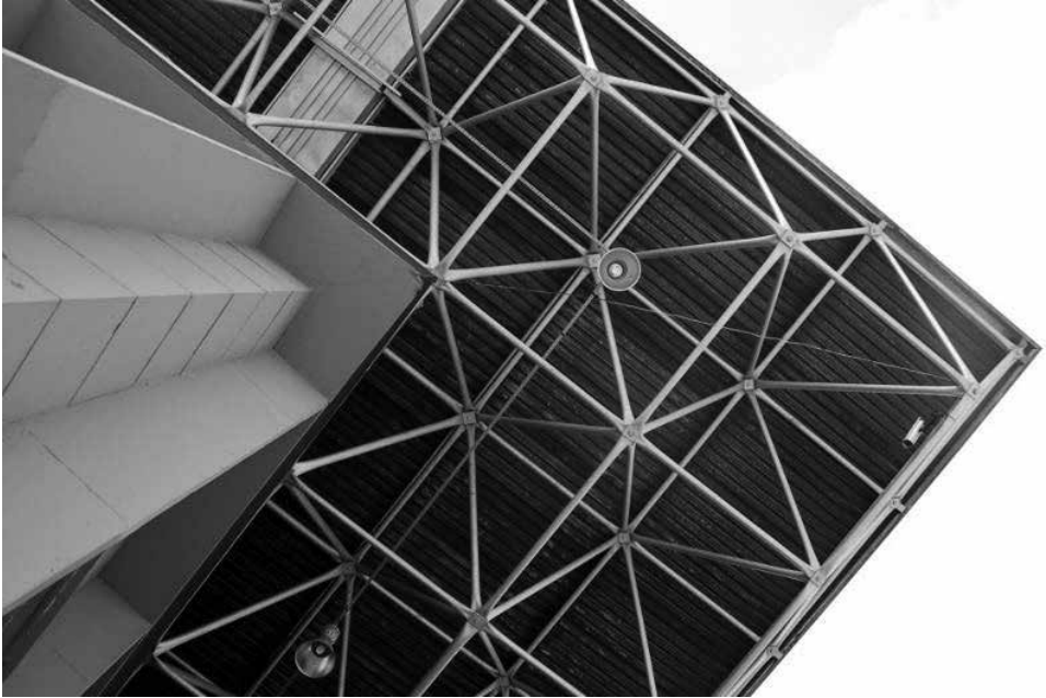
Figura 29 – Fábrica da Bombril-NE. Coordenação entre os sistemas de vedação e cobertura.
