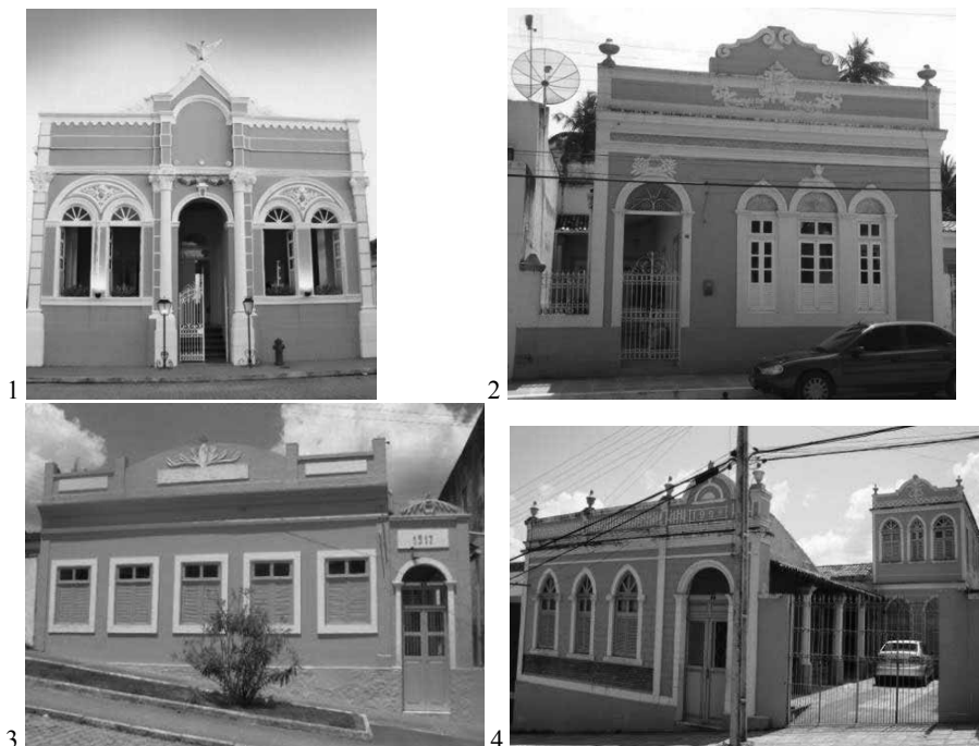
Figura 1 – Exemplares de tônica eclética. 1. Antiga Intendência Municipal. 2. Casa com entrada lateral, 1920. 3. Casa com entrada lateral, 1917. 4. Fonte: Casa paroquial, 1928. Acervo Inventário do Patrimônio Arquitetônico, Viçosa/AL, 2011.
