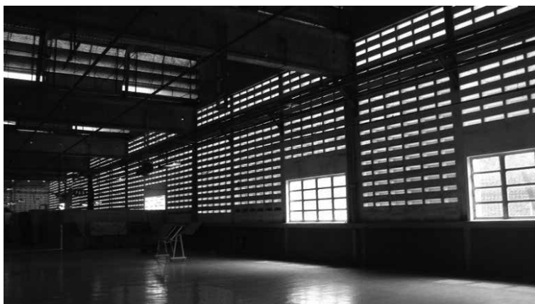
Figura 7 – Elementos vazados, vista do interior do edifício.
