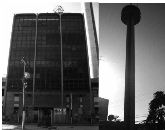
Figura 14 – Edifício sede da Secretaria Municipal de Saneamento (SESAN). Foto: Renata Gribel, 2011.
