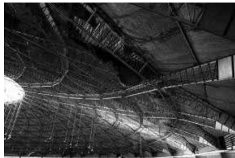
Figura 23 – Foto da cobertura (atual) com a inserção das placas de madeira. Foto: Fernando Diniz.
