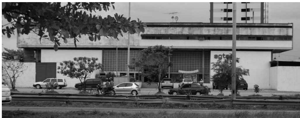
Figura 15 – AGTEC. Fachada Principal. Fonte: acervo dos autores.
