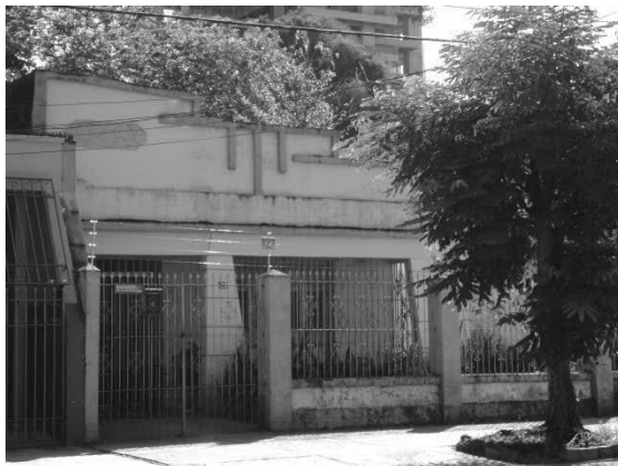
Figura 7 – Edificação residencial coroada por platibanda art déco, com linhas geométricas ascendentes que prenunciam a linguagem moderna na arquitetura. Foto: Renata Gribel, 2011.
