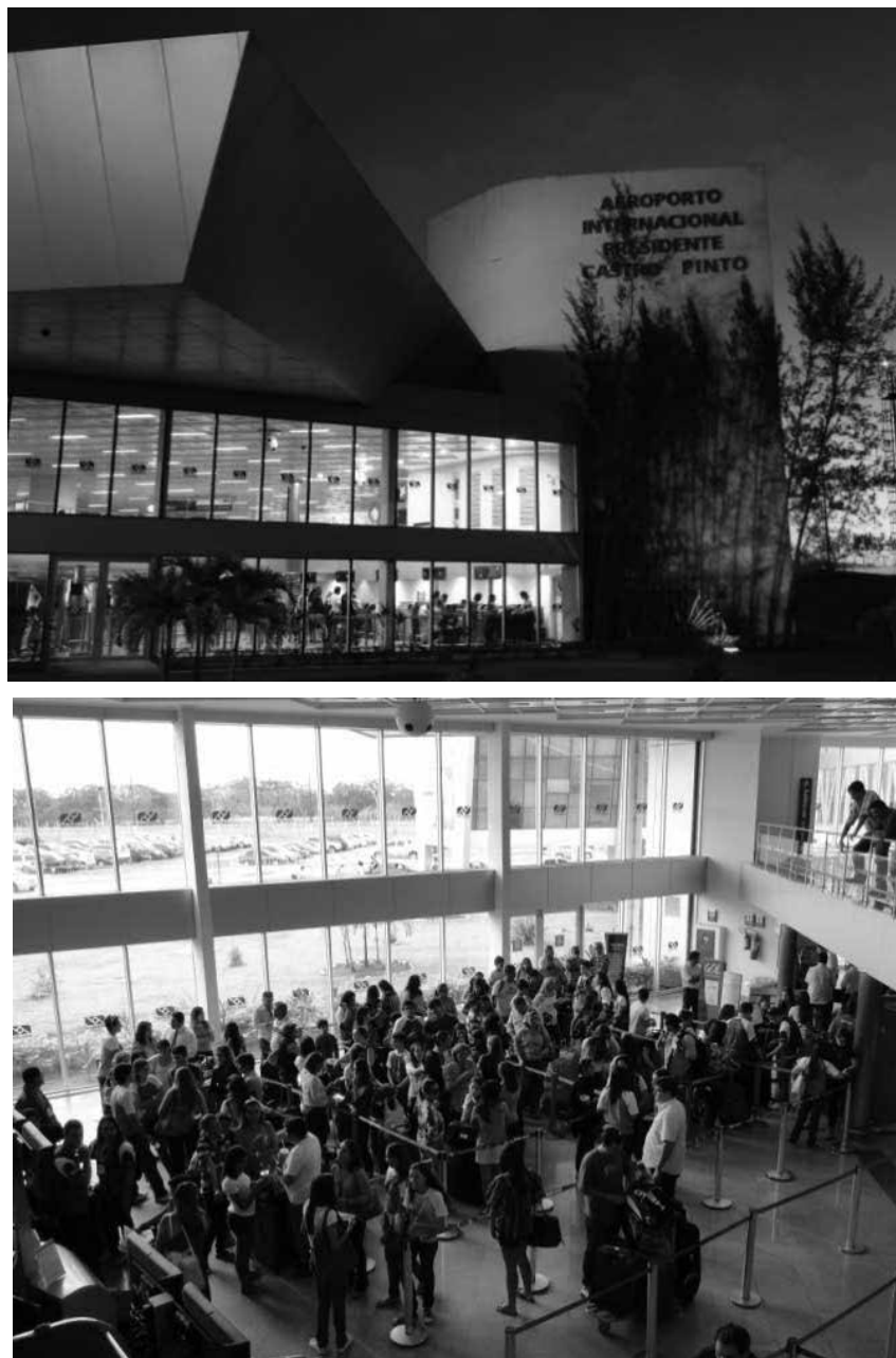
Figuras 7, 8 – Vista externa e interna do Aeroporto Castro Pinto, após a reforma. Fonte: Arquivo do Aeroporto Castro Pinto.
