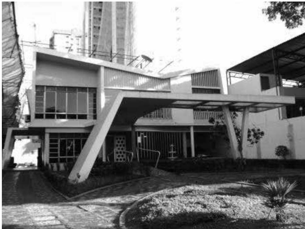
Figura 4 – Residência Bittencourt (1955), do engenheiro Camilo Porto de Oliveira. Foto: Renata Gribel, 2011.
