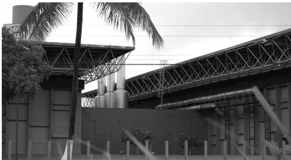
Figura 27 – Fábrica da Bombril-NE. Tubos de exaustão e painel em relevo. Fonte: Acervo dos autores. Foto: Fernanda Mafra.
