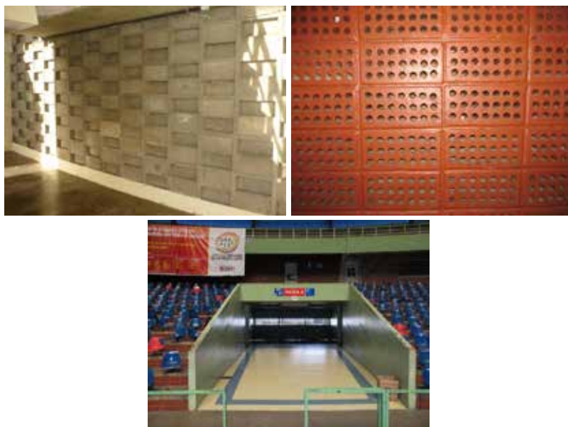
Figura 25 – Cobogós de concreto, tijolo furado e acesso do ginásio. Fonte: Geossistemas Engenharia & Planejamento.
