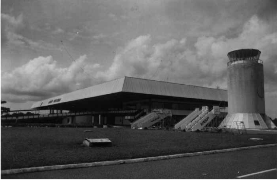
Figura 5 – Vista da torre de controle e rampa de embarque, antes da reforma. Fonte: Arquivo do Aeroporto Castro Pinto.
