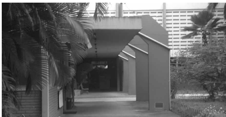
Figura 9 – Apoios unilaterais da passarela que une o galpão de produção e o setor de administração.
