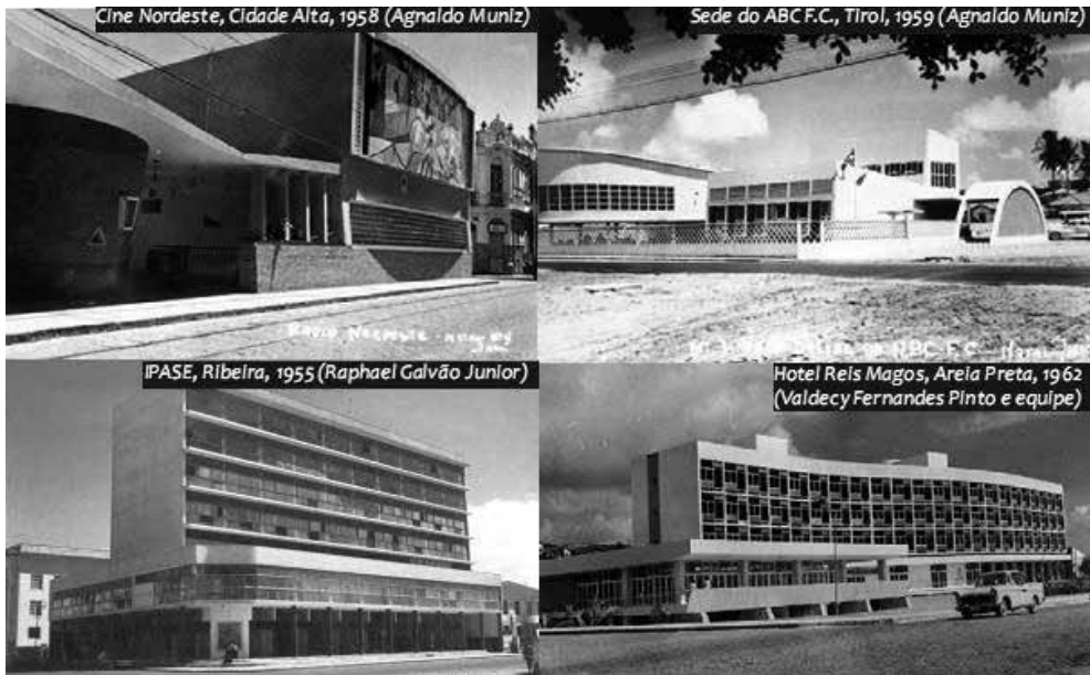
Figura 4 – Prédios modernistas de Natal construídos nas décadas de 1950-60. Fonte: Melo, 2004.
