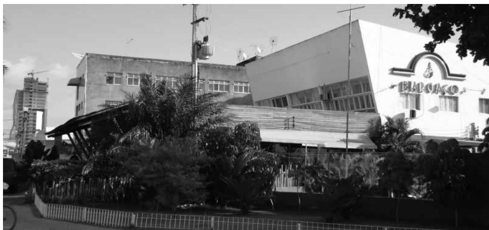
Figura 18 – Terraço “rústico” implantado sobre a fachada do Clube Líbano Brasileiro: à procura de um ângulo de onde a fachada inclinada e sua janela em fita ainda sejam perceptíveis. Fonte: Natália Vieira, fevereiro de 2012.
