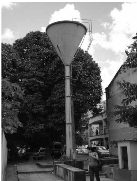
Figura 5 – Caixa d'água. Fonte: Arquivo Fernando Moreira.
