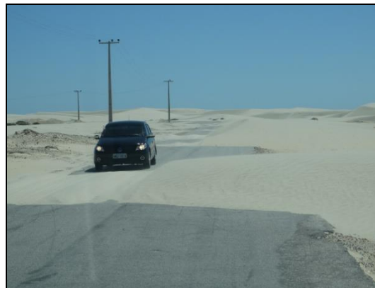
B-Trecho da ampliação da RN 404
