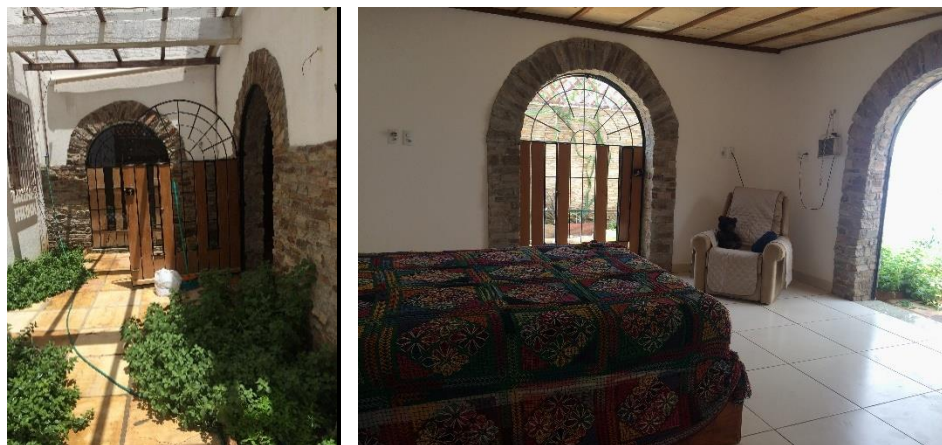
Figura 33: Foto das paredes largas e pergolado protegendo as aberturas
