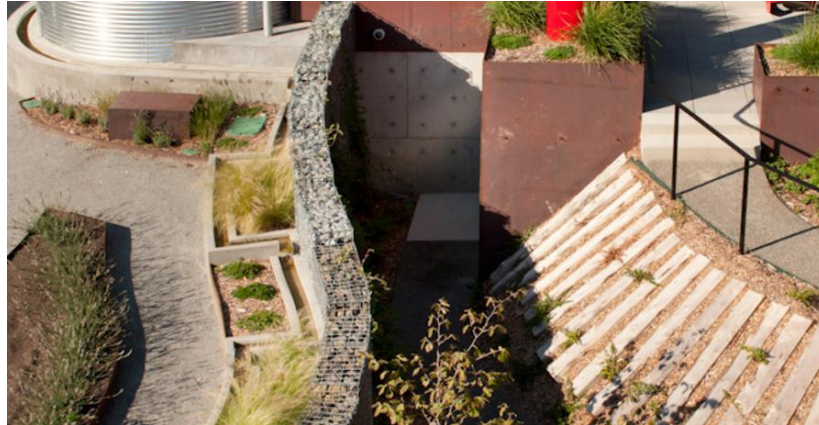
Figura 13: Foto das valas de infiltração do Campus GreenFire
