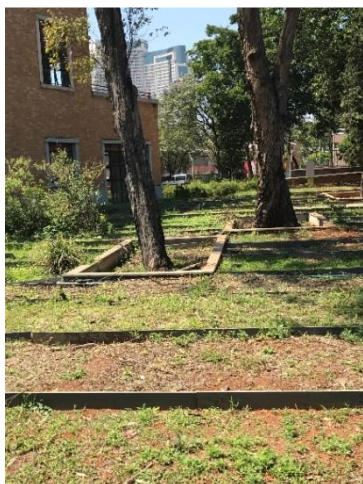
Figura 30: Foto do sistema de Alagados Construídos
