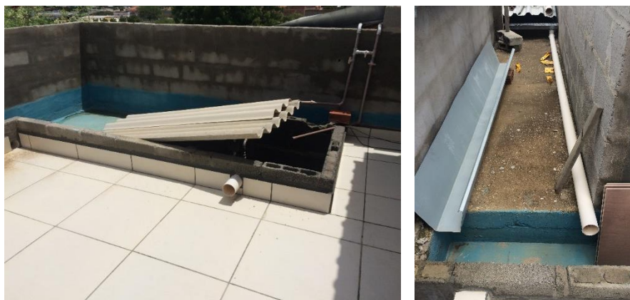
Figura 35: Foto do detalhe das calhas e reservatório superior
