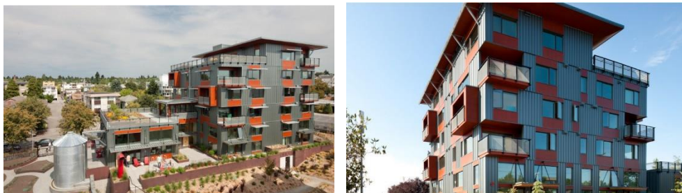
Figura 12: Mosaico de imagens – Fachadas do Edifício do Campus GreenFire
