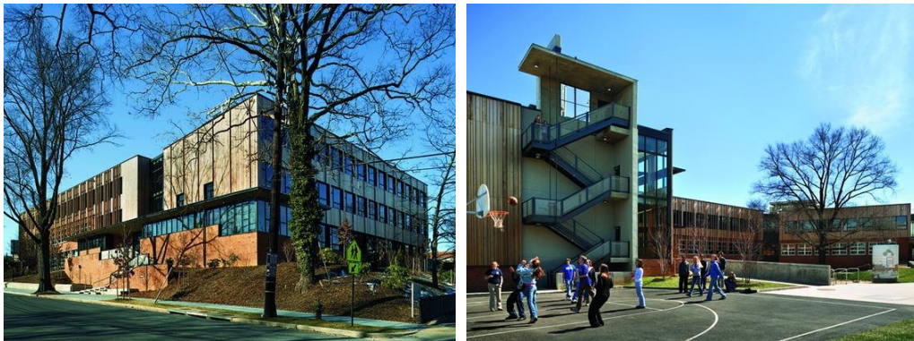
Figura 18: Mosaico de fotos da fachada do edifício Sidwell Friends School
