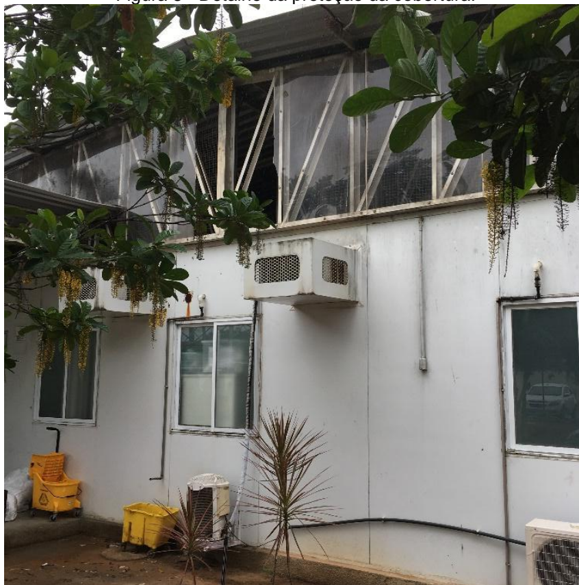
Figura 8 - Detalhe da proteção da cobertura.
