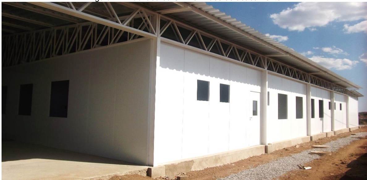
Figura 2 - Fachada da UPA em fase de acabamento.
