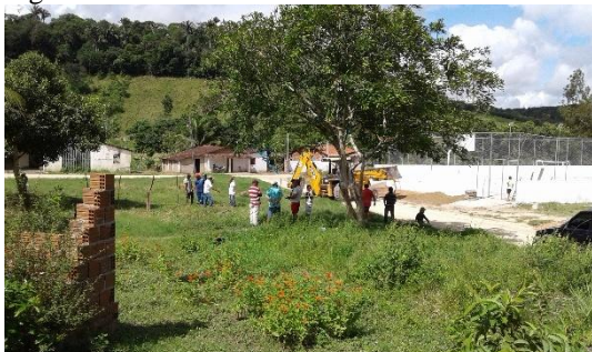
Figura 23 Cerca sendo derrubada
