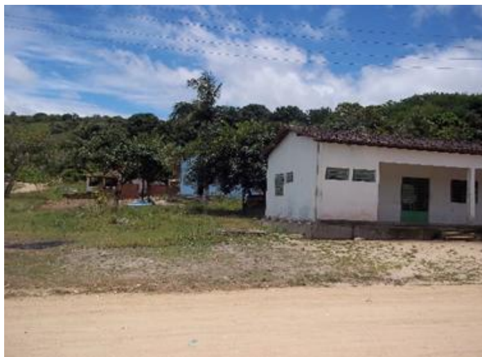
Figura 25 Vista do prédio da associação dos homens, localizado na via de acesso principal da agrovila. Nos fundos, podem ser visualizadas parte da Igreja Católica, de cor azul, e da APROAGRO.
