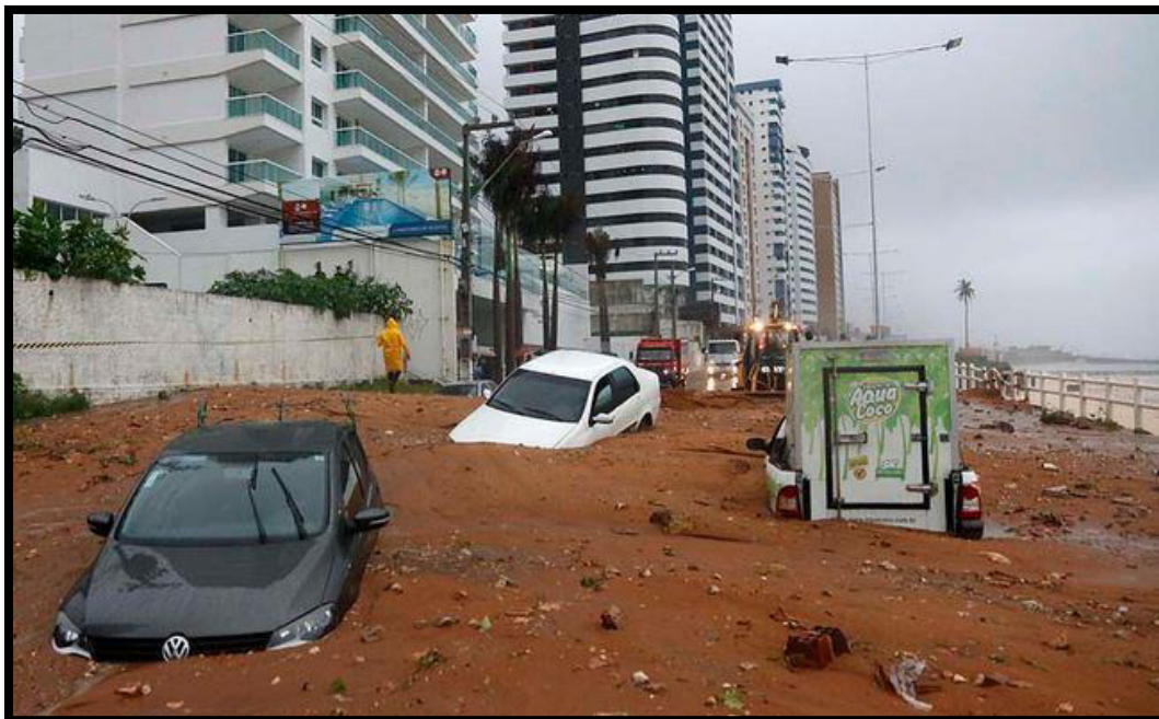
Figura 2.6: Soterramento de carros na Avenida Silvio Pedrosa em 15/06/2014. Fonte: Fotojornalismo Canindé Soares.
