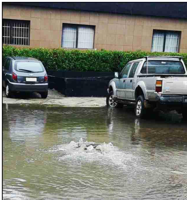
Figura 5.6: Transbordamento de poço de visita do sistema de esgoto durante alagamento na Rua Açú após evento de precipitação intensa em 13/04/2018.
