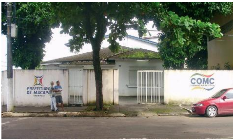
Figura 10 - Prédio da Fumcult.
