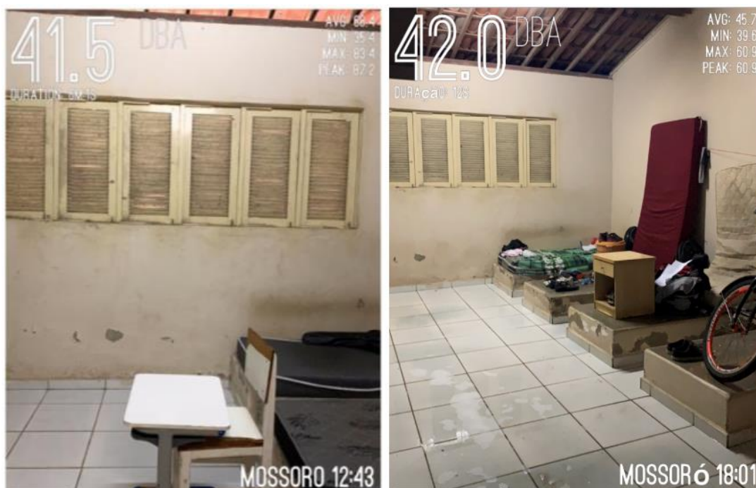
Figura 47 - Vilas Acadêmica – Medição de Ambiente Interno - Dormitórios
