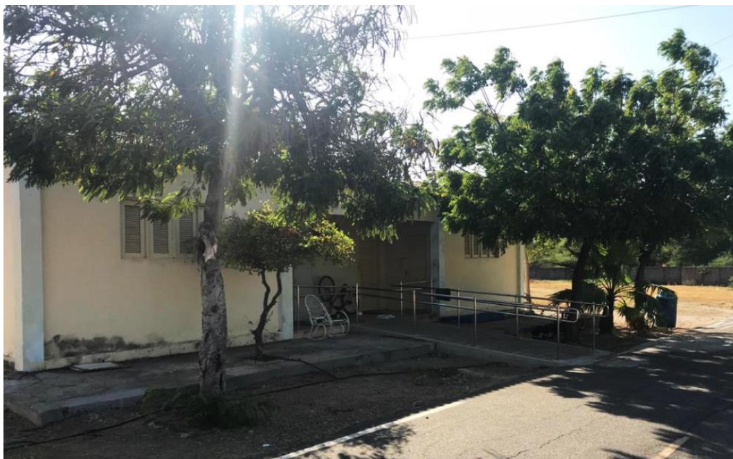
Figura 55 – Reforma de acessibilidade realizada na casa 17
