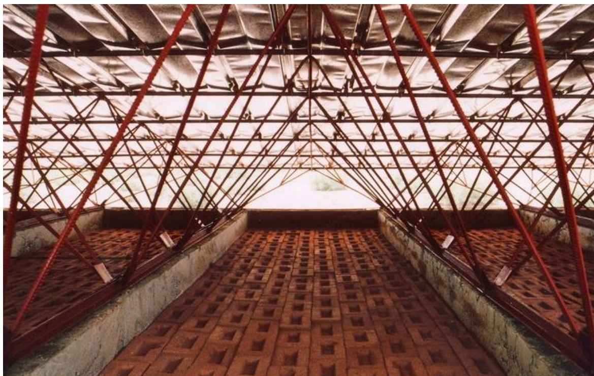
Figura 13 - Cobertura da Escola Primária
