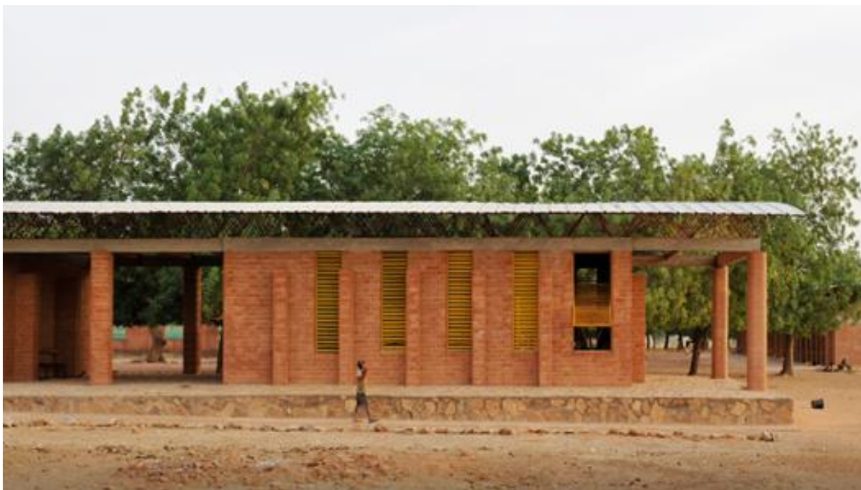
Figura 12 -Paredes em argila - Lateral da Escola Primária
