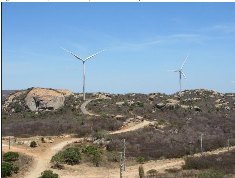
Figura 18 – Aerogeradores do Parque Eólico Pedra Rajada II – Cerro Corá/RN.
