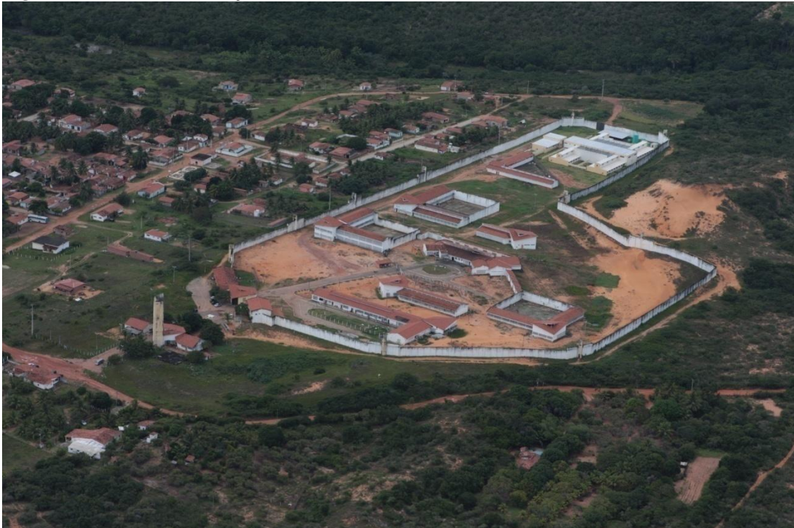
Figura 1 - Vista aérea de Alcaçuz
