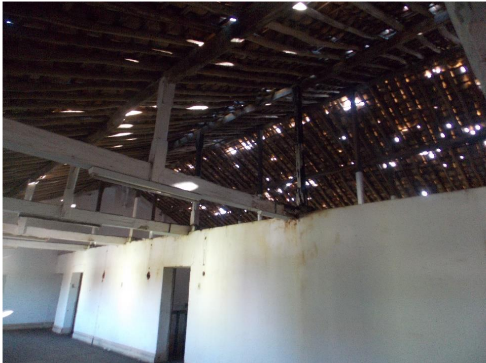
Figura 67: Estruturas do telhado em pontalete
