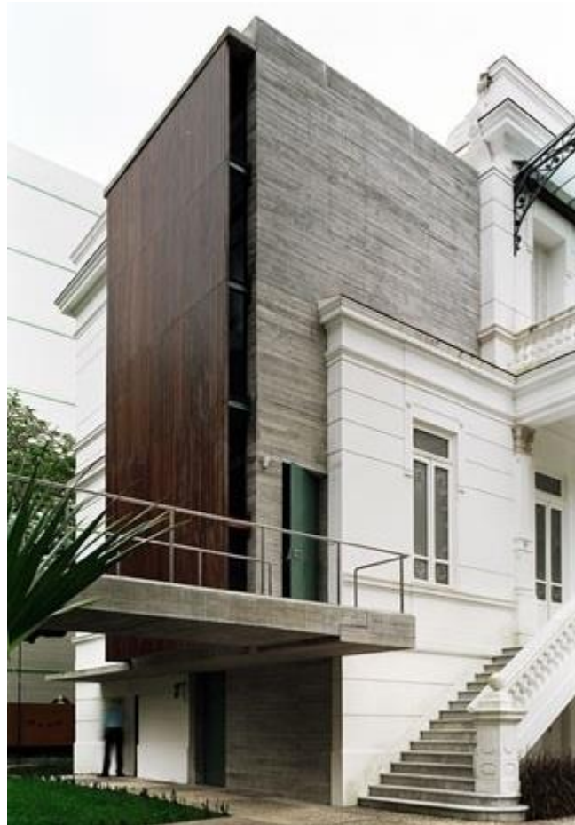
Figura 38: Anexo contíguo do Palacete
