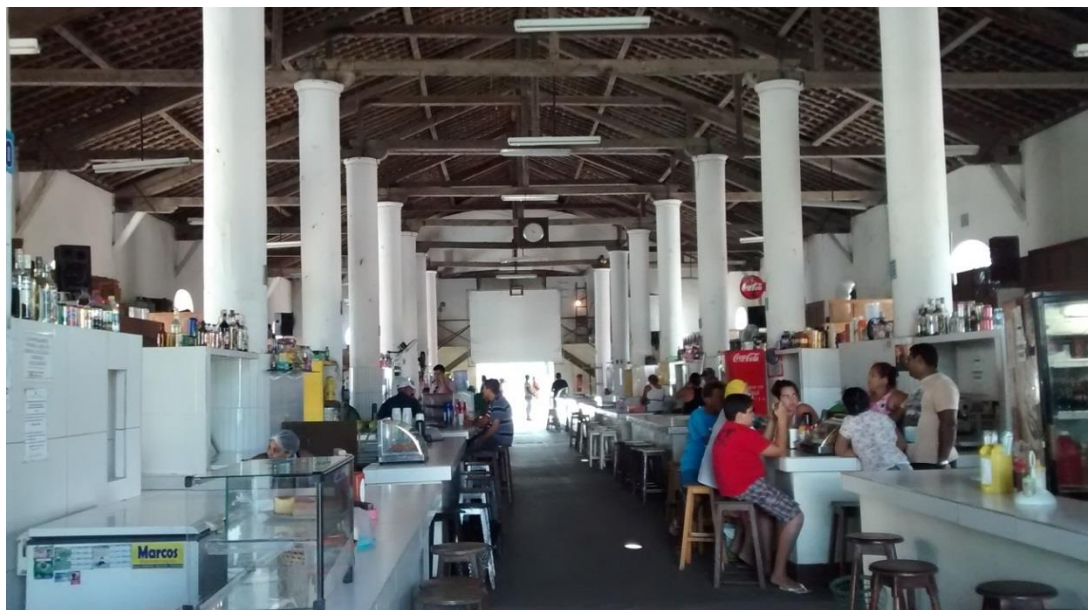
Figura 12: Interior do Mercado mostrando colunas de sustentação e pontaltes da cobertura
