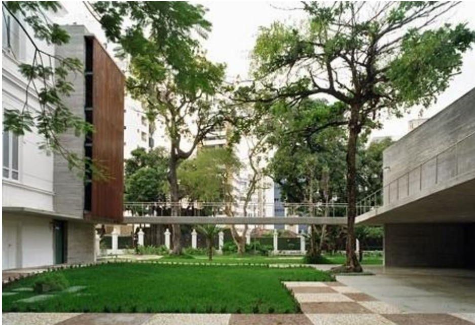
Figura 39: Elemento de ligação entre os edifícios
