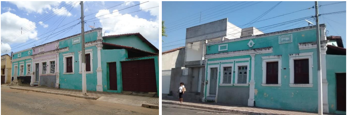
Figura 08 e 09: Descaracterização de conjunto edificado de casa histórica na Rua Heráclito Vilar
