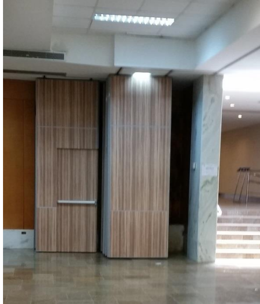
Figura 14: Armazenagem das divisórias.
