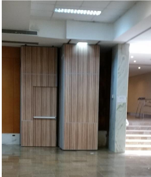
Figura 14: Armazenagem das divisórias.
