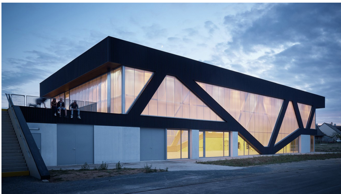
Figura 24 - Terraço externa - fachada norte.
