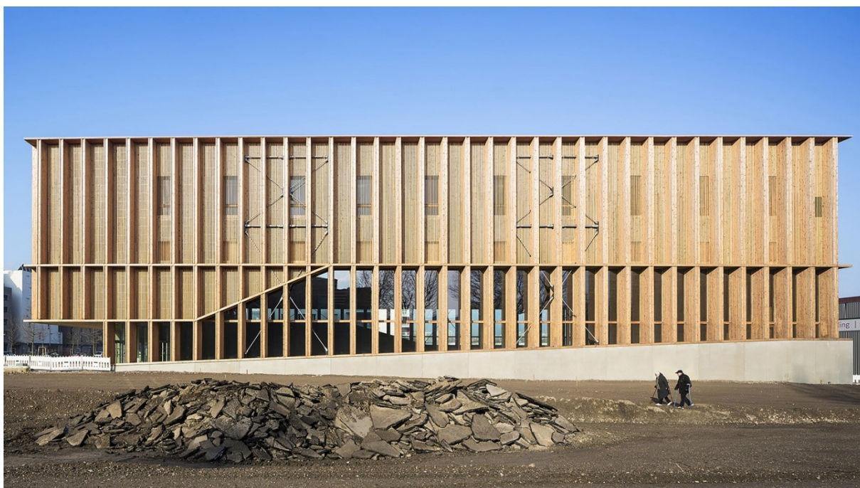
Figura 19 - Elementos verticais - fachada sul
