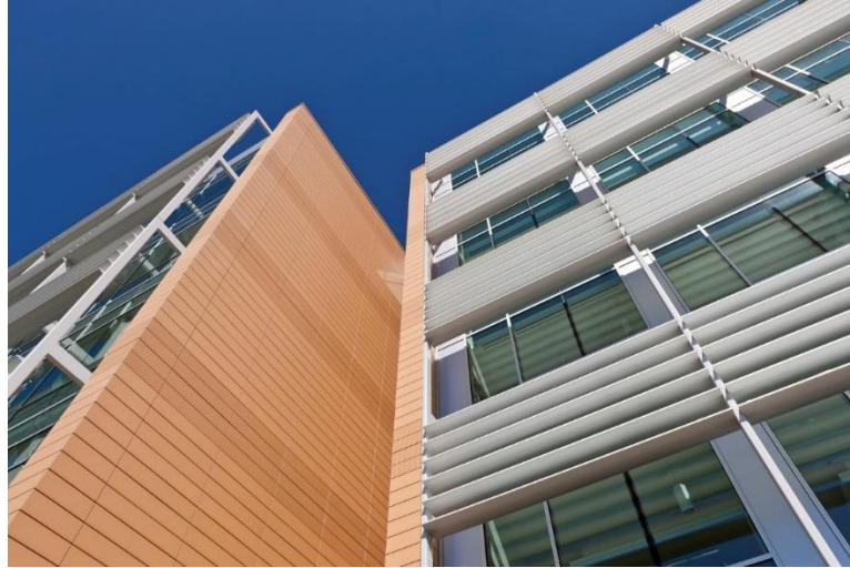
Figura 15 - Brises na fachada
