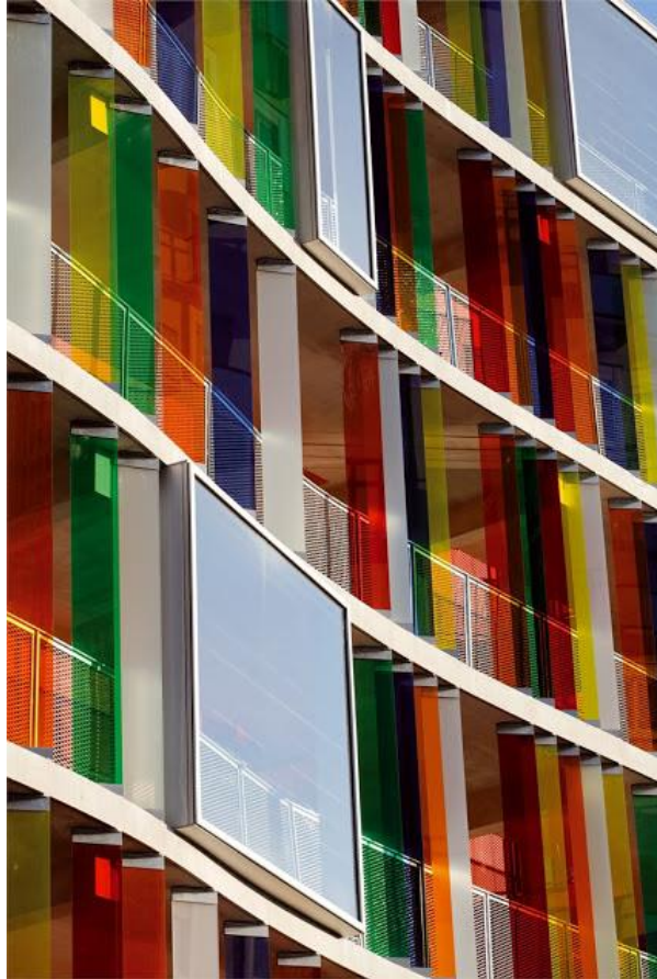
Figura 27 - Detalhe de brise na fachada
