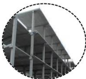
PRE-MOLDADO DE CONCRETO
