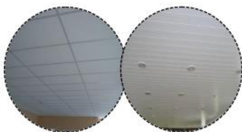
FORRO DE GESSO ACARTONADO E PVC
