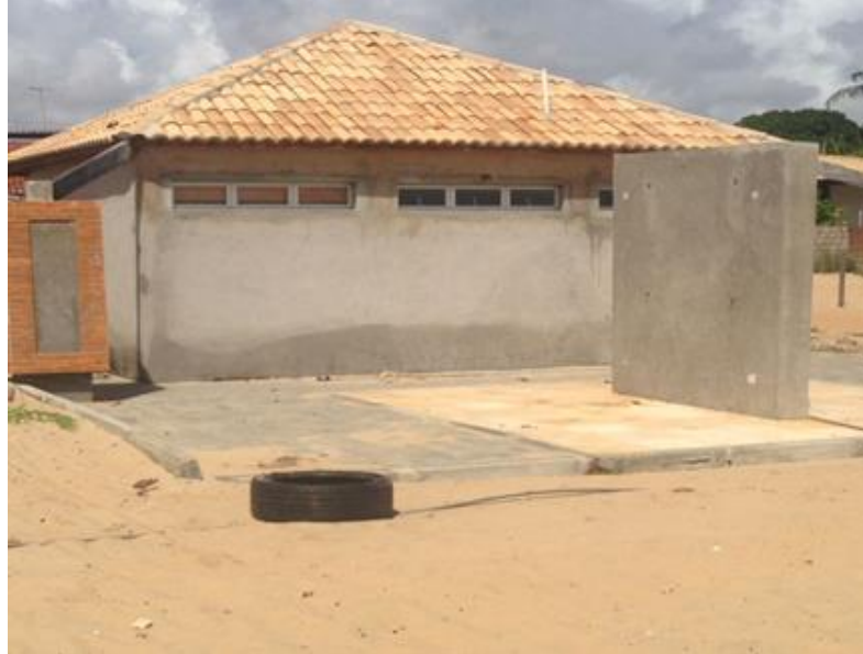
Figura 19- Construção de novo centro de apoio aos bugueiros da região.
