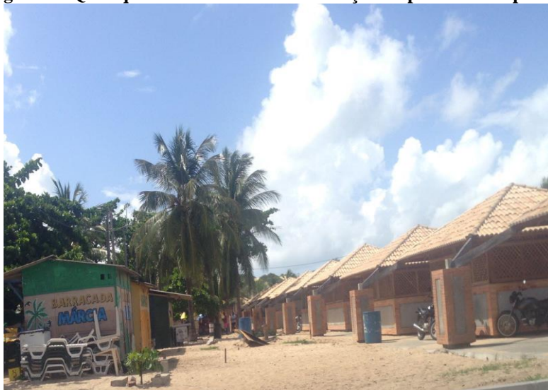
Figura 17-Quiosques em fase final de construção na praia de Jenipabu.
