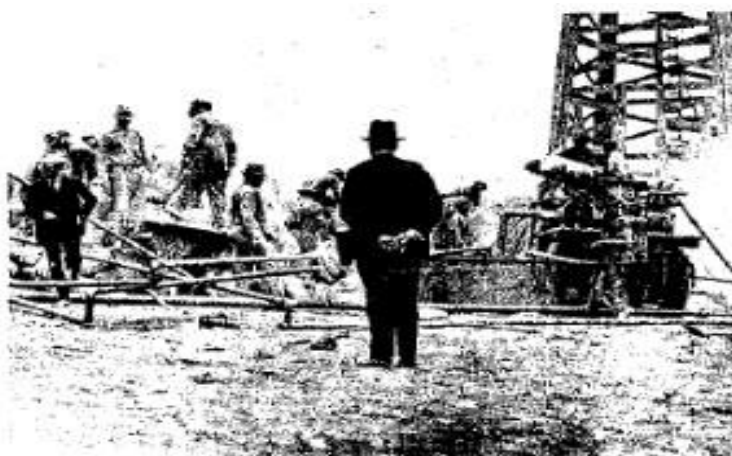
Figura 2 - Cimentação nos anos de 1920.
