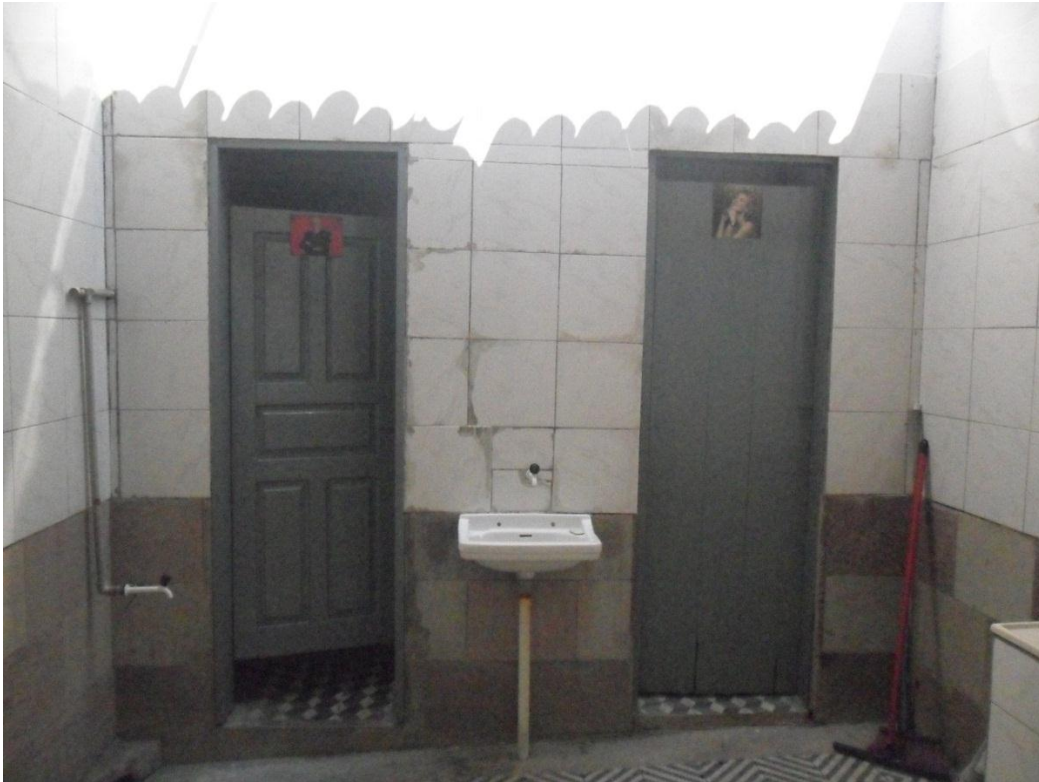
Banheiros da Biblioteca Municipal.
