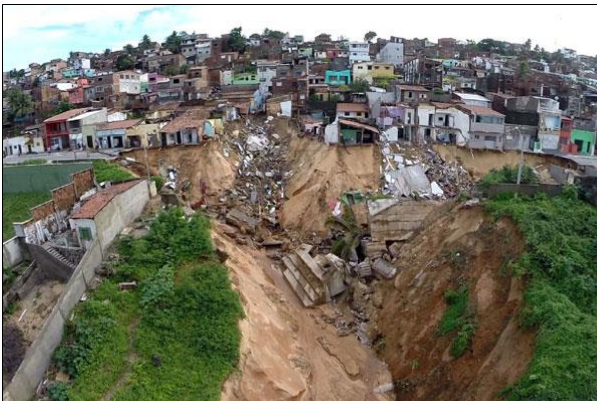
Figura 15: Deslizamento de terra ocorrido em Natal/ RN em junho de 2014.
