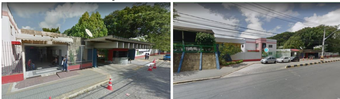
Imagem 43: Fachada do IFRN no trecho 05.
