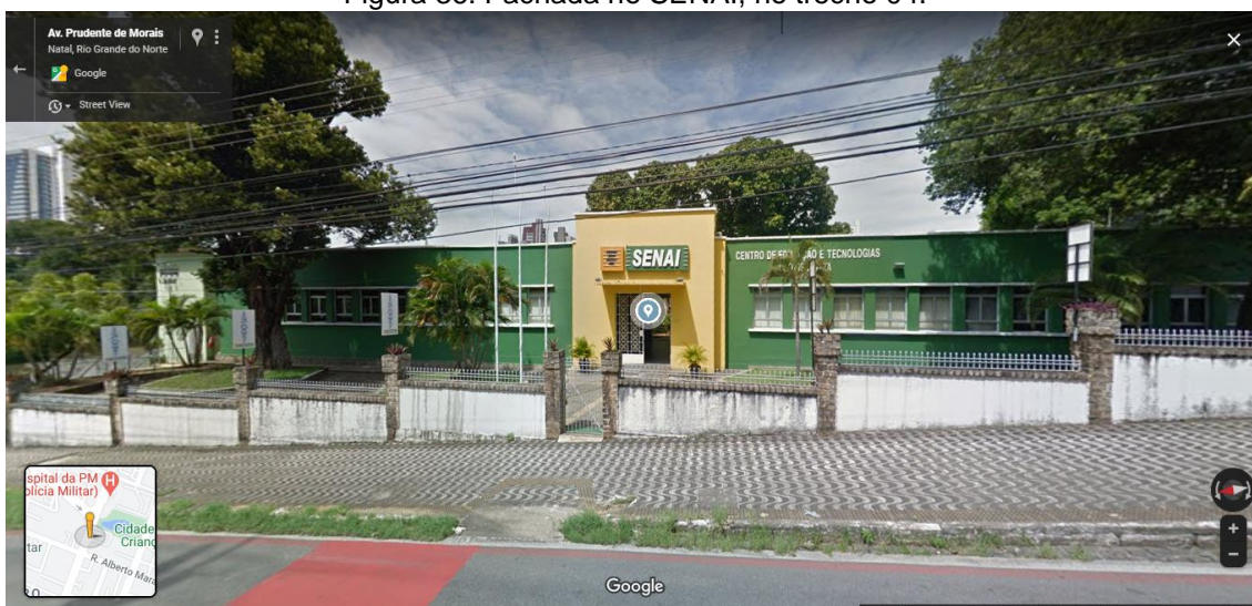
Figura 36: Fachada no SENAI, no trecho 04.
