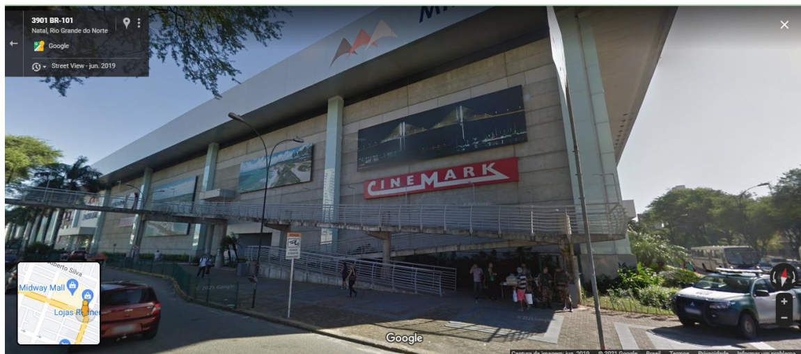
Figura 44: Esquina do trecho 01 e 05, fachada mostrando a passarela calçada.
