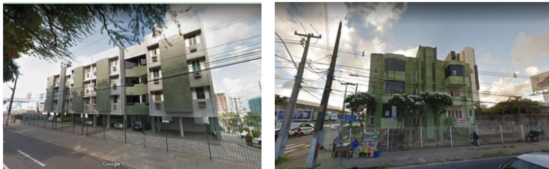
Figura 39: Residências multifamiliares que permitem a permeabilidade visual.
