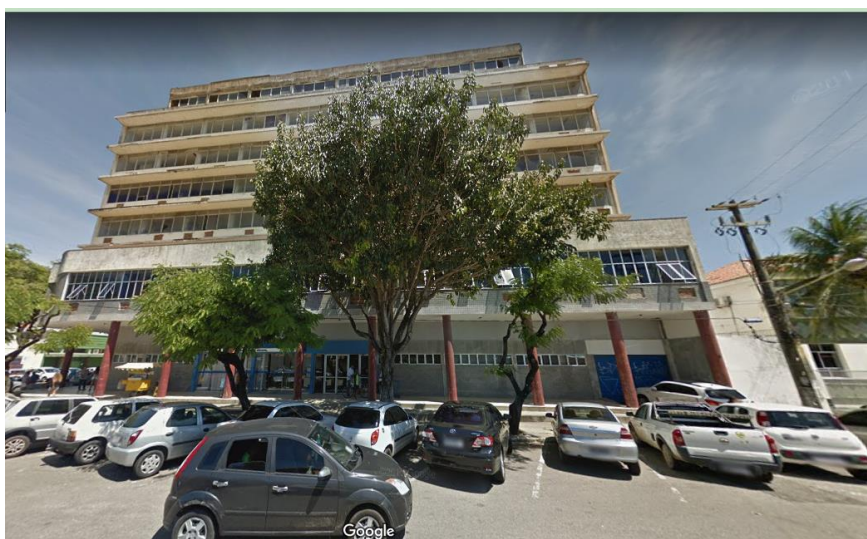
Figura 65: Fachada principal do edifício Presidente Café Filho
