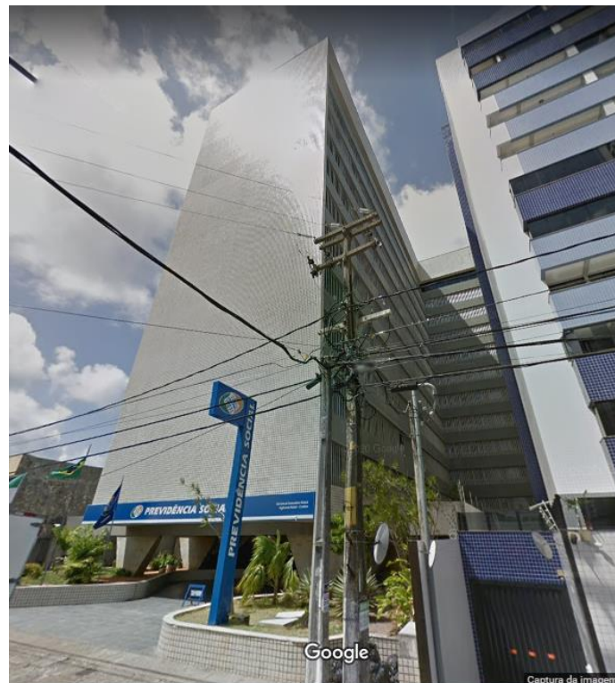
Figura 50: Fachada do INSS com brises verticais fazendo o fechamento parcial.
