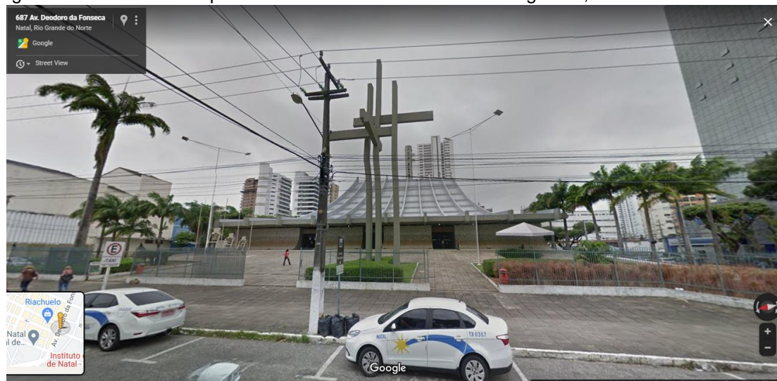
Figura 34: Catedral Metropolitana de Natal com fechamento de grades, localizado no trecho 03.
