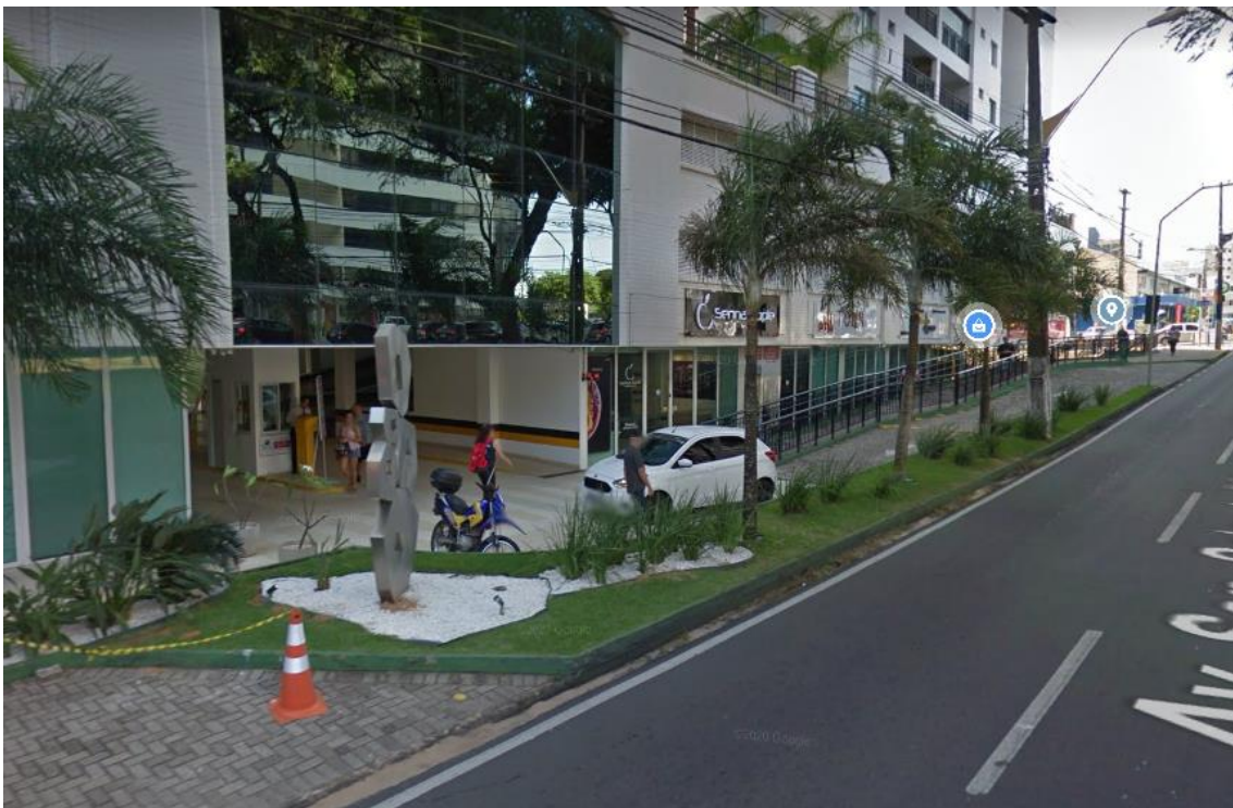
Figura 53: Acesso dos veículos no edifício comercial Tirol Way.
