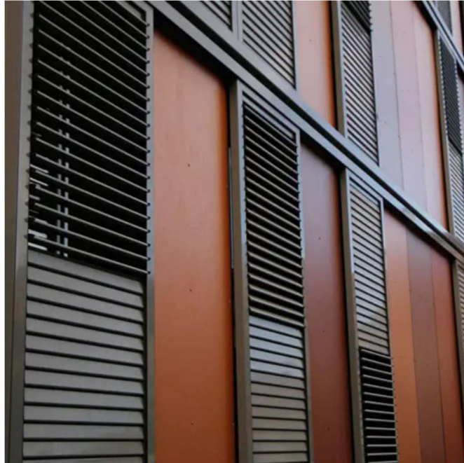
Figura 60: Exemplo de esquadria de alumínio de correr com paletas reguláveis
