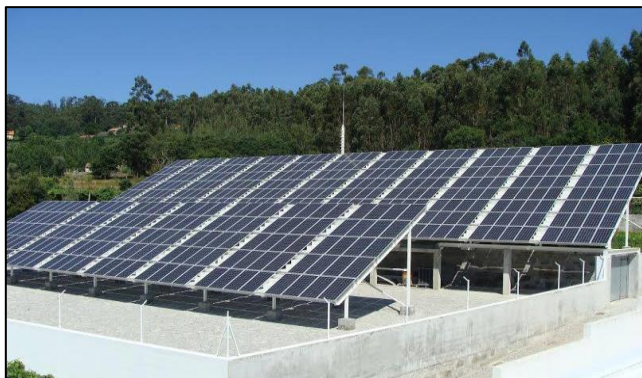
Figura 3.2 – Parque de estacionamento na empresa portuguesa ProduCanelas.
