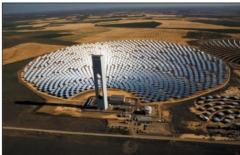
Figura 3.11 – Foto de usina heliotérmica com torre solar configuração.
