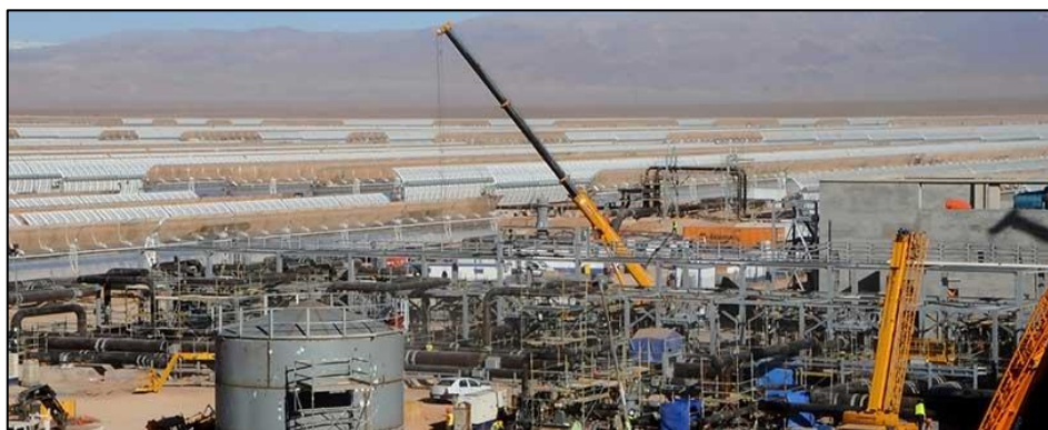
Figura 4.6 – Construção dos Trabalhos de Construção da usina NOOR 1.
