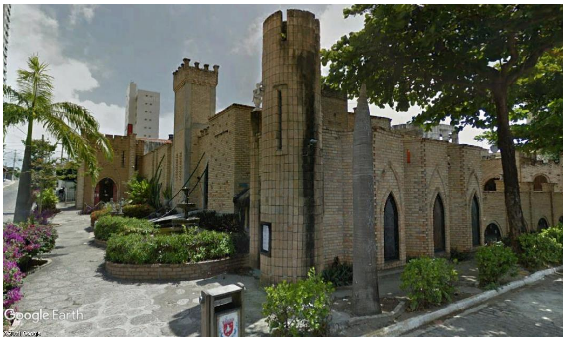
Figura 1: Edificação que faz representação da arquitetura medieval europeia, em Natal/RN
