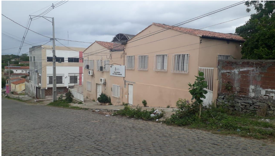
FIGURA 2 – Fachada da Escola Municipal Olivia Pereira Rodrigues
