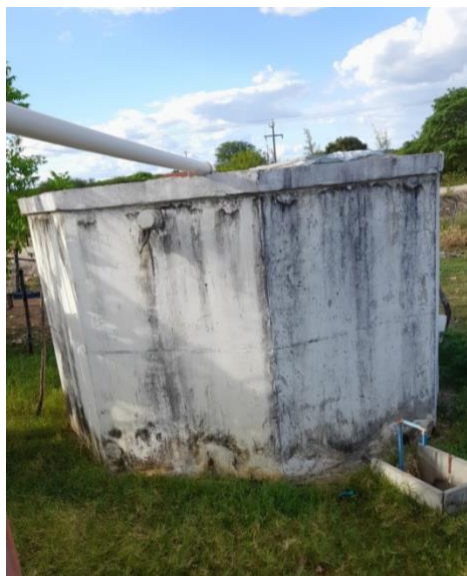
Figura 5: Cisterna da FUNASA construída na comunidade São Francisco
