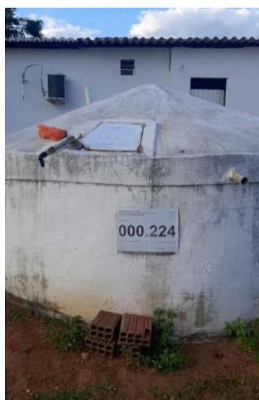
Figura 4: Cisterna do P1MC construída na comunidade São Francisco
