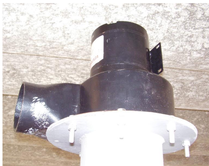
Figura A.9: Exaustor de gases para o meio ambiente
