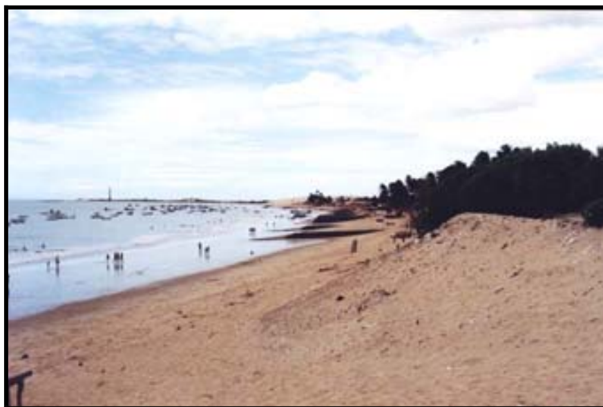
Perfil P6 – foto 06: Visão parcial do campo de dunas na cidade de Caiçara do Norte. Ao fundo nota-se a presença dos gabiões distribuídos ao longo da praia. Fotografado em 08/04/2001, às 11:05hs (foto do Autor)
