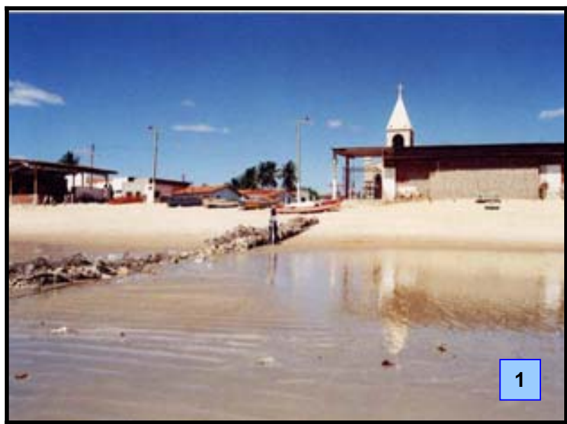
Figura 6.2 – Seqüência de fotos ( 1 a 12) mostrando parte das residências e dos gabiões implantados na faixa de praia na cidade de Caiçara do Norte. Em destaque nota-se a arquitetura dos gabiões e o estado de conservação dos mesmos. Dos 14 gabiões construídos pela prefeitura de Caiçara do Norte cerca de 85% deles foram parcialmente ou completamente destruídos pela ação das ondas e/ou pela população local. (fotos: 05/7/2001, às 12:00hs, foto do autor)
