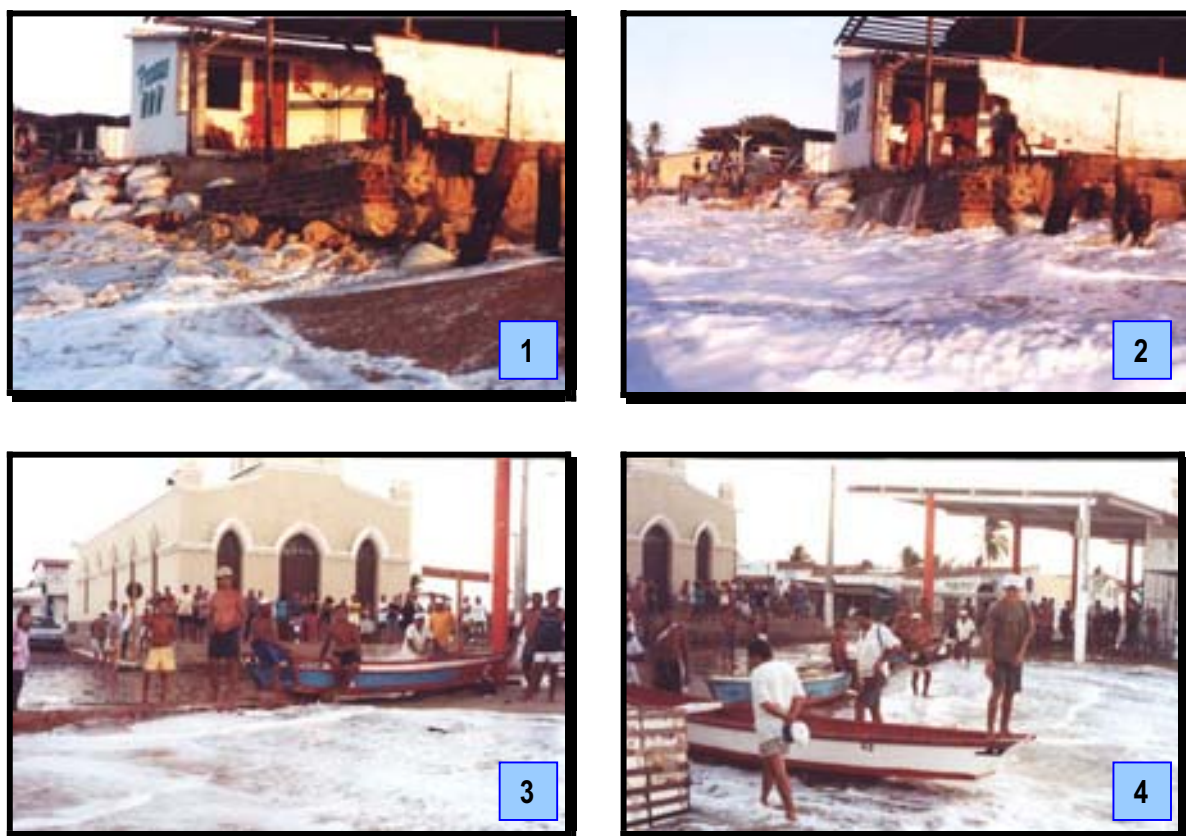
Figura 4.9 – Cidade de Caiçara do Norte (área do perfil 4 e 5) – Instante em que mar invadiu a cidade, registro do efeito catastrófico da maré excepcional ocorrida em fevereiro que provocou alagamento e destruição nas principais ruas da cidade (seqüência de eventos 1 a 4). Altura da maré 2.8m (preamar 18:06hs), direção do vento 260°az, sentido da corrente 270°az. Registro realizado no dia 10/02/2001, às 17:30hs (fotos do autor).
