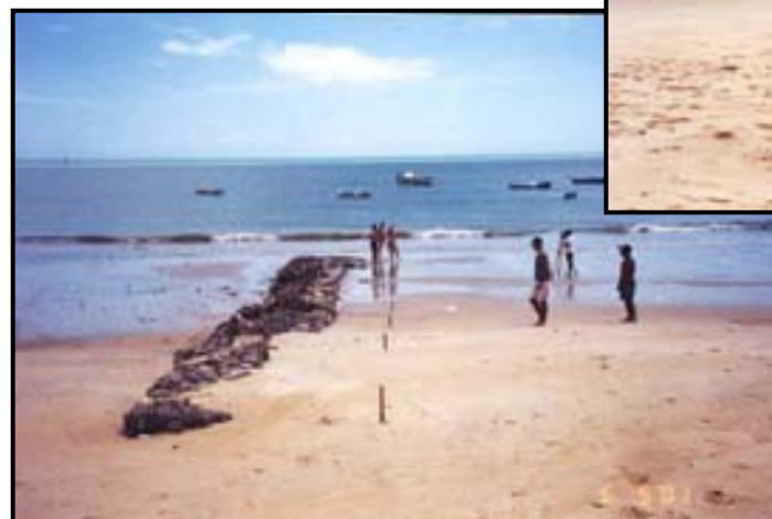
Figura 4.8 – Perfil P4 e P5 - As fotos mostram o posicionamento do Gabião na praia de Caiçara do Norte. Observar a variação morfológica e a taxa sedimentação no área. Na foto ao lado destaca-se a destruição dos gabiões e a baixa resistência do material que os recobre. 10/02/2001, às 11:24hs (baixa mar 11:06hs 0,1m ; fotos do autor).
