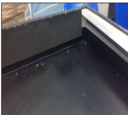
Figura 41: Fixação do restante do isolamento
