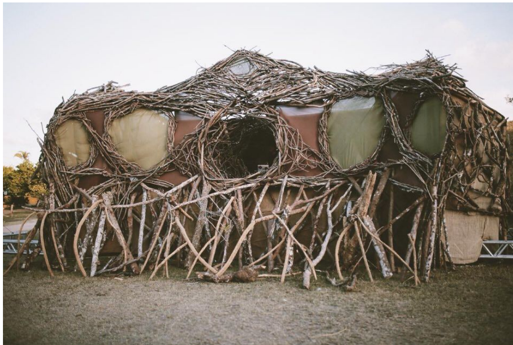
Figura 16 - Detalhe do palco do Festival Boikot, edição 2018, em Altinho, Pernambuco. O palco foi totalmente construído pelo Coletivo, utilizando de técnicas de bioconstrução.
