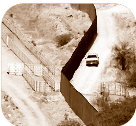
Fig. 1 - Muro que está sendo construído entre os EUA e o México
