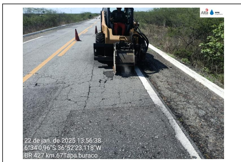
Figura 21 - Fresagem do revestimento no serviço de reparo localizado, BR-427/RN
