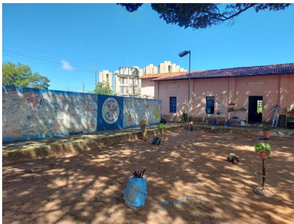
Fotografia 2 - Vista lateral da parte externa do CECCO Natal
