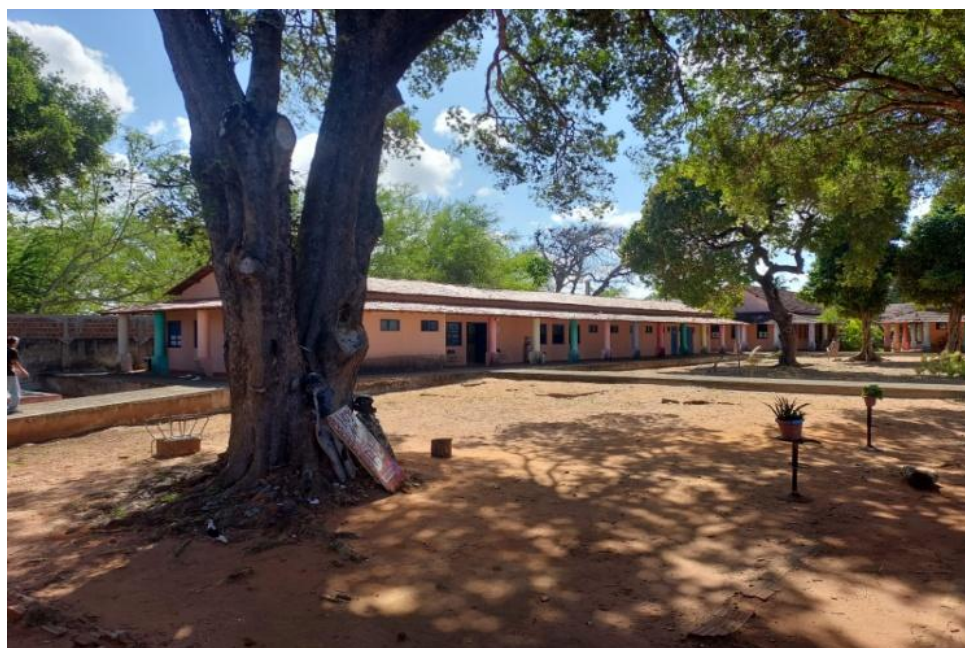
Fotografia 4 - Construção que abriga o refeitório, banheiros e salas utilizadas pelos três serviços
