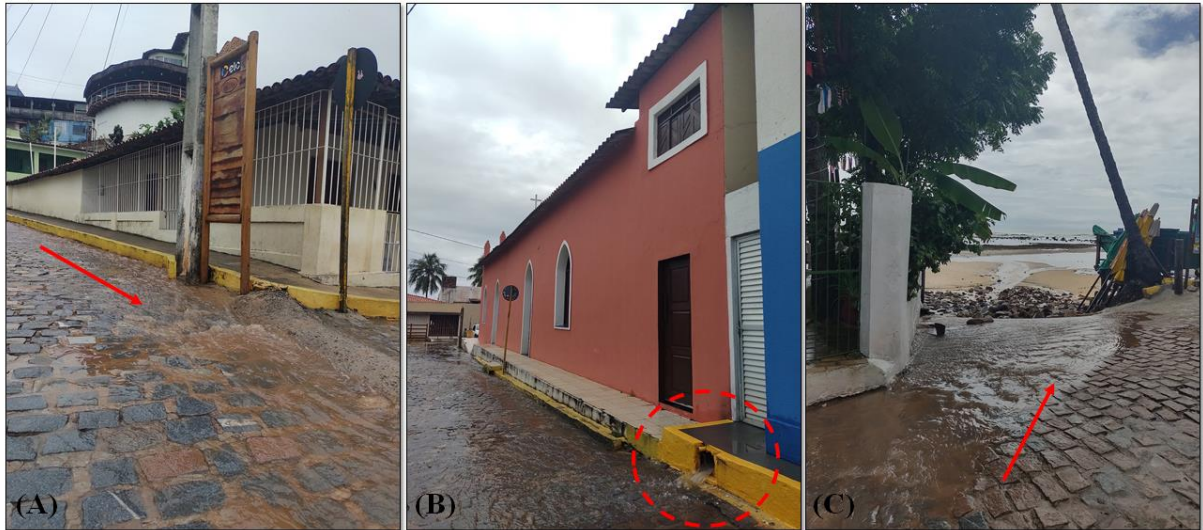
Figura 43 – Pontos de escoamento de água registrados; (A) Fluxo de água em direção à praia; (B) Lançamento de esgoto proveniente do excedente do sistema instalado; (C) Um dos pontos de chegada do escoamento na praia e potencialização do processo de erosão.
