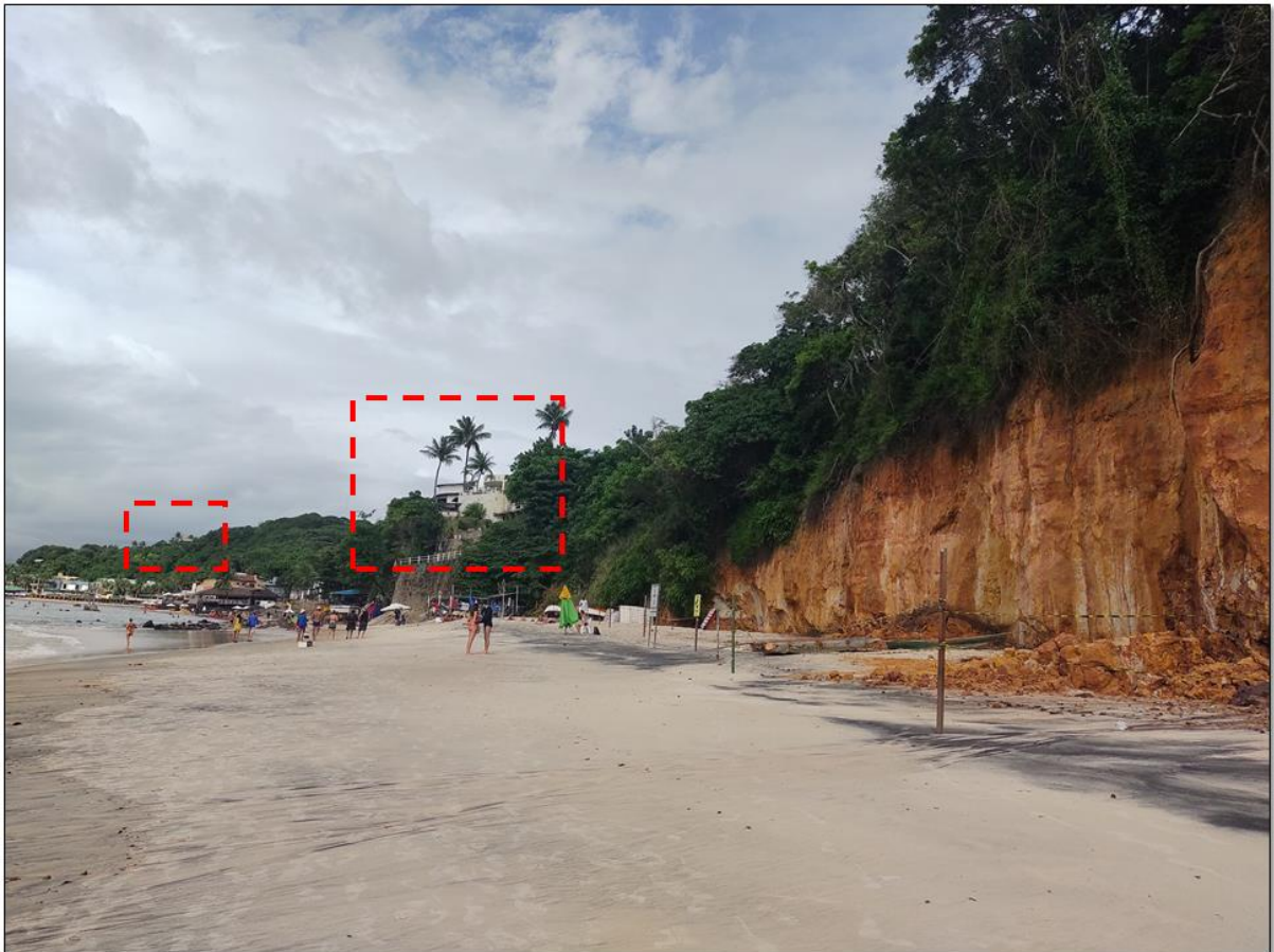
Figura 9 - Destaque (em vermelho) para edificações construídas inadequadamente no topo da falésia, promovendo um acréscimo de carga que pode levar à ruptura da rocha.
