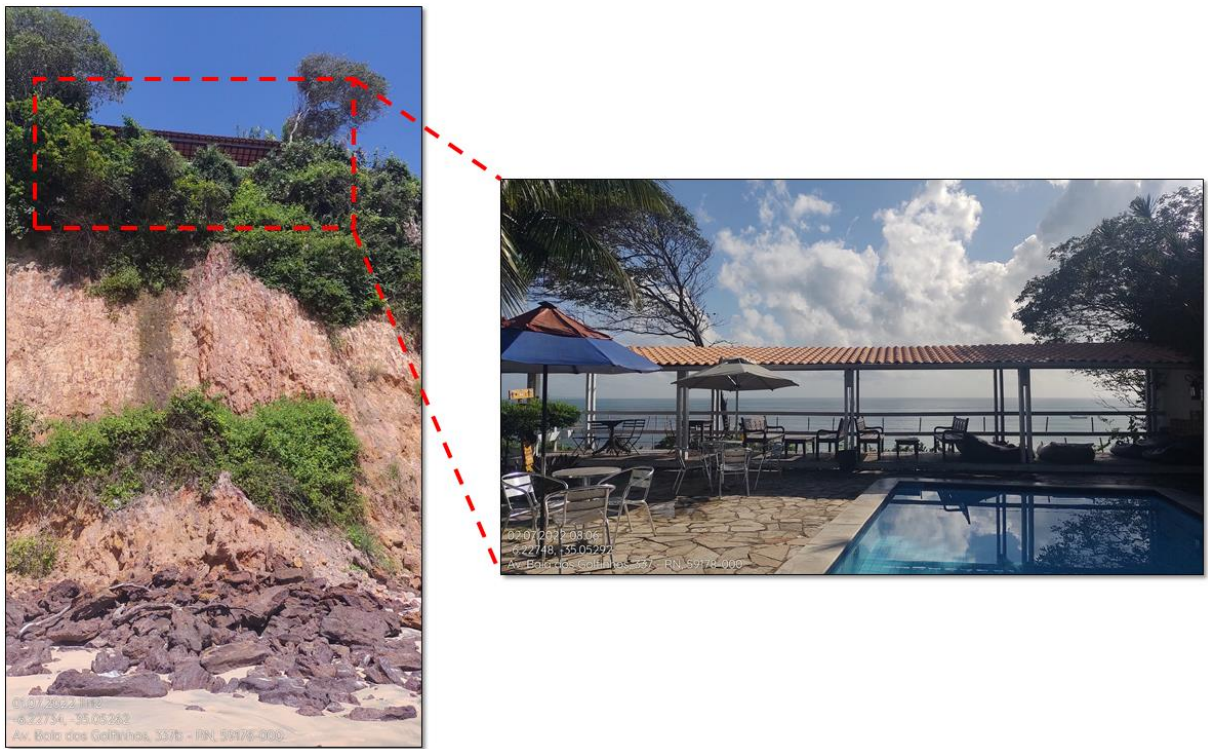
Figura 10 - Movimento de Massa das Falésias. Destaque (em vermelho) para um empreendimento construído inadequadamente no topo da falésia, neste mesmo local.
