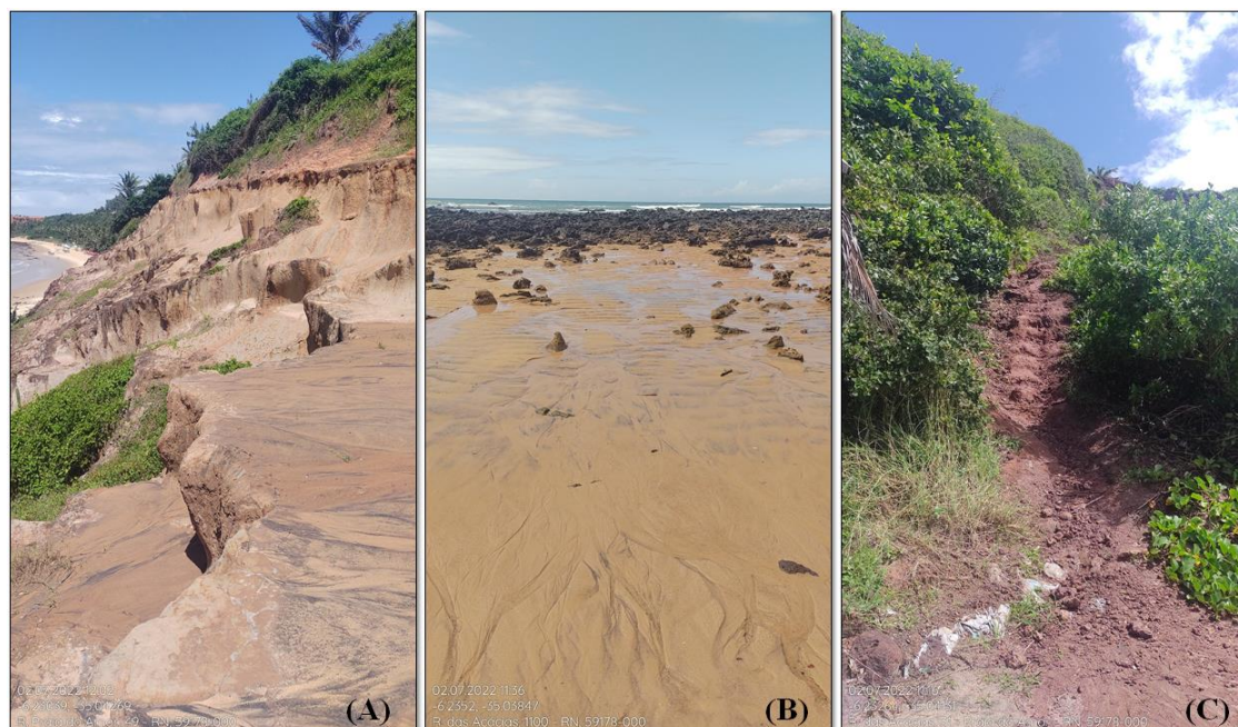
Figura 44 – Evidências de processos erosivos no Setor NE; (A) Erosão no topo da falésia; (B) Afloramento do lençol freático; (C) Abertura de acesso à praia.
