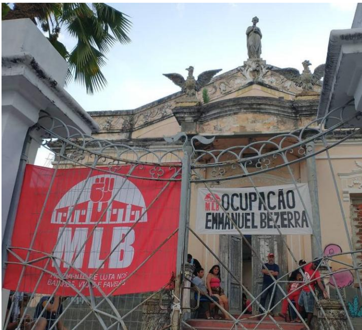
Figura 77: Fachada Ocupação Emmanuel Bezerra
