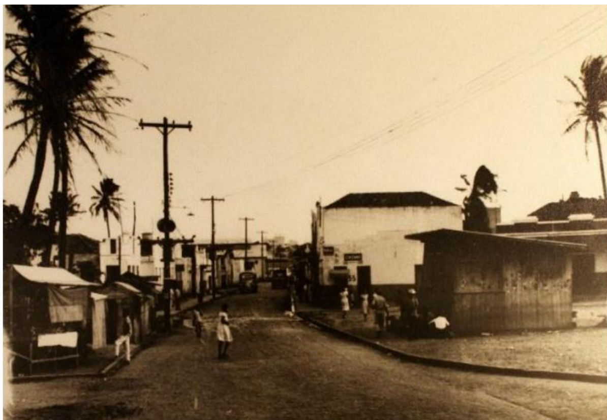
Figura 23: Rua Expedicionário José Varela, na Rocas, antes (1946) e depois (1948) de obras de pavimentação. Fonte: Arquivo Sílvio Pedroza, apud Bentes Filho, 2023.
