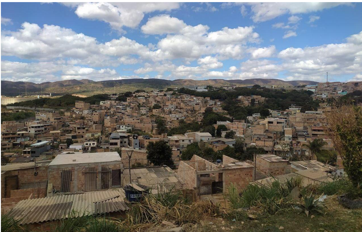
Figura 6: Ocupação Paulo Freire (MLB) no Vale das Ocupações na região do Barreiro, Belo Horizonte, MG. Fonte: Autor, 2024.
