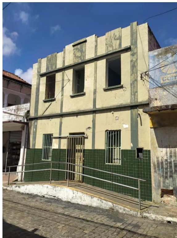
Figura 68: Edificação após saída da ocupação. Fonte: Miró Aires, 2024.
