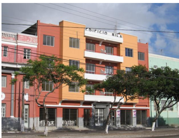
Figura 34: Edifício Bila após recuperação. Fonte: Brechando, 2023.
