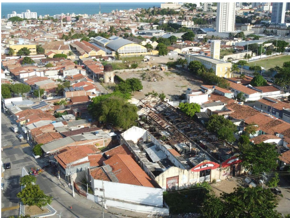
Figura 97: Vista aérea sobre a Ocupação Palmares Fonte: Arquivo CPOP, 2024.
