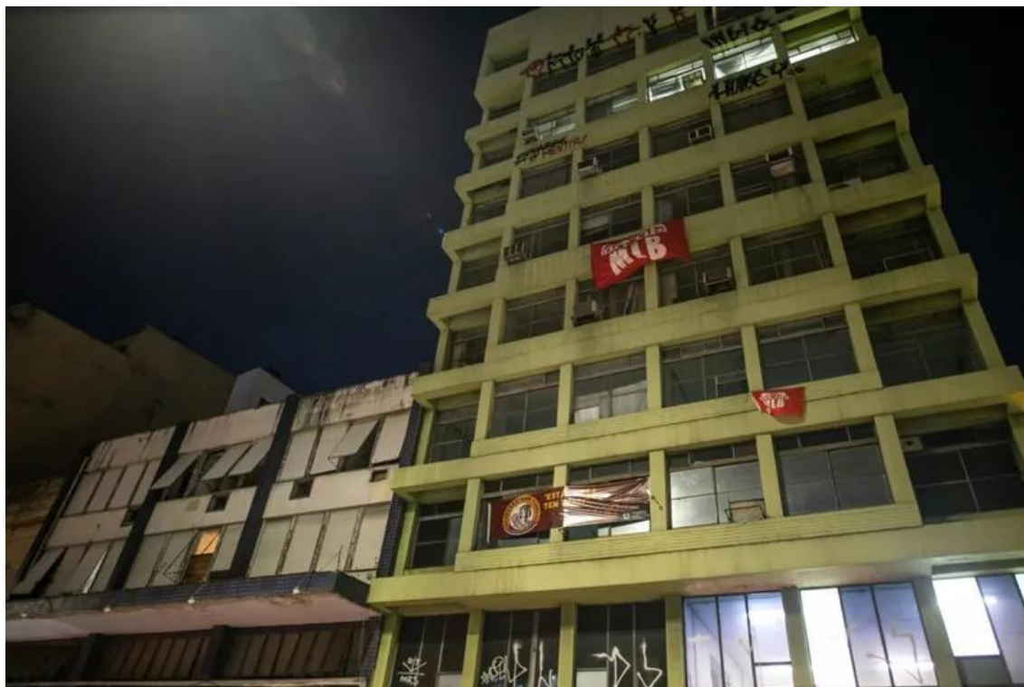
Figura 55: Ocupação Sepé Tiaraju (MLB RS), em Porto Alegre, atualmente em processo de elaboração de projeto para Retrofit via PMCMVE, em prédio da União. Fonte: Brasil de Fato, 2024.
