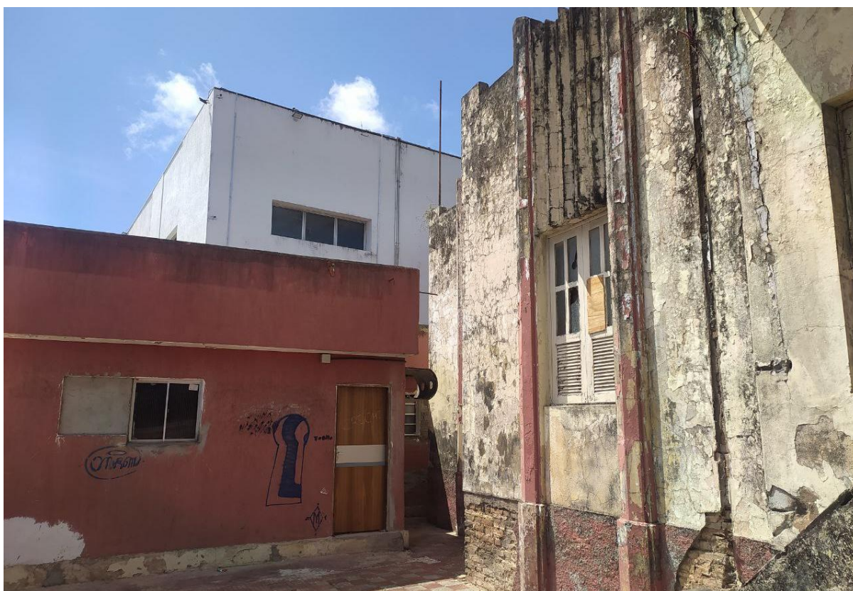
Figura 87: Edificação lacrada (em primeiro plano) e pequeno anexo, onde pretendem instalar a creche da ocupação. Fonte: Miró Aires, 2024.
