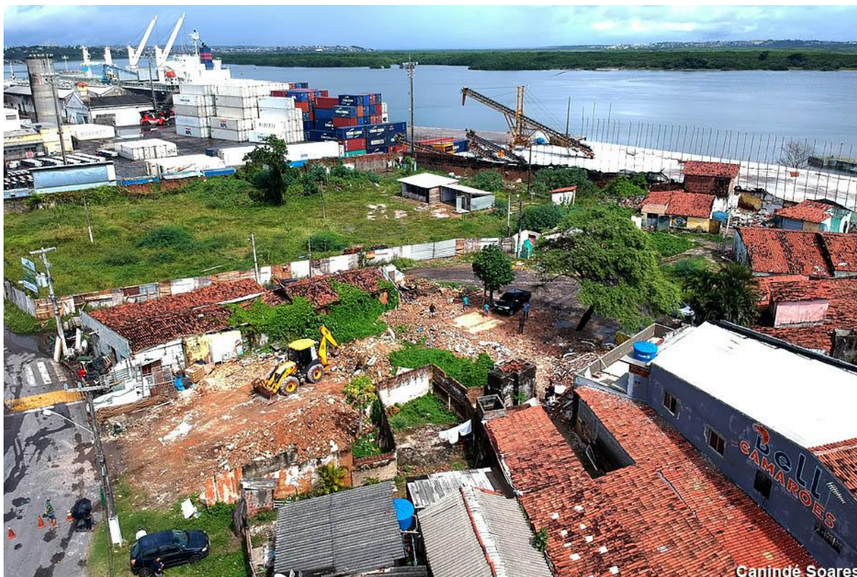
Figura 39: Demolição de casas no Maruim para início de obras de urbanização. Fonte: Canindé Soares, 2018.
