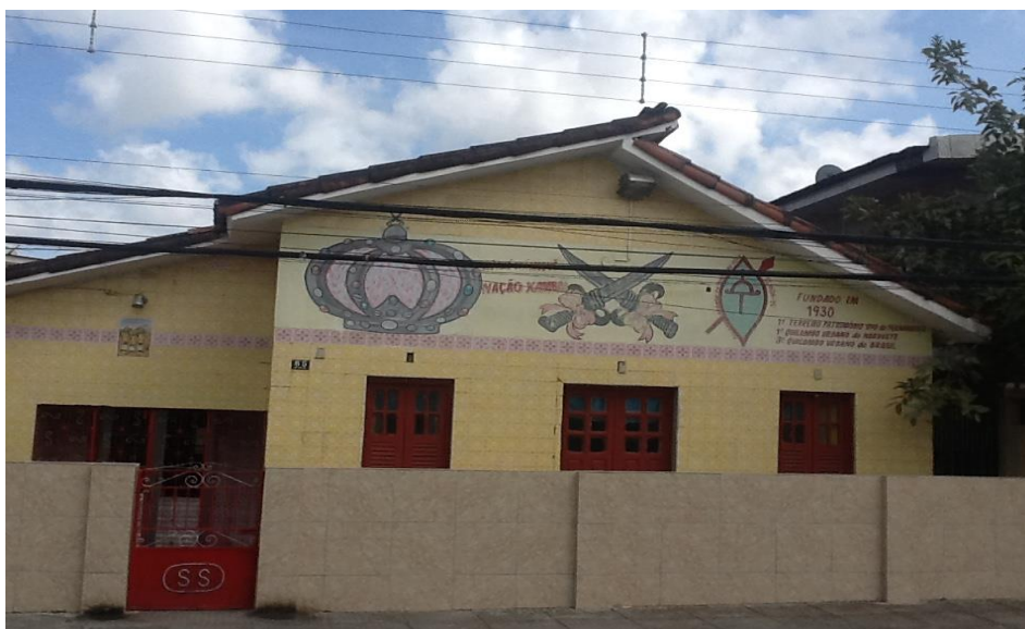
Fachada do terreiro da Nação Xambá. Fonte: Foto tirada em 2018 pelo autor, Olinda/PE
