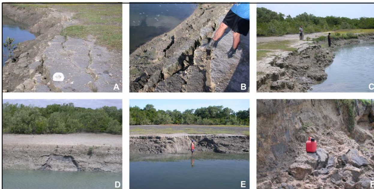
Figura 8.20. Deslizamentos, queda de blocos e feições erosivas na margem esquerda do CD1 em frente aos perfis P3 e P4: Fendas longitudinais paralelas ao canal (A), feições erosivas escalonadas (B) e (C), escorregamento no P3 (D) e P4 (E), e queda de bloco no P3 (F). As planícies de supramarés (C, D e E) são completamente inundadas durante as marés de sizígia de enchente.
