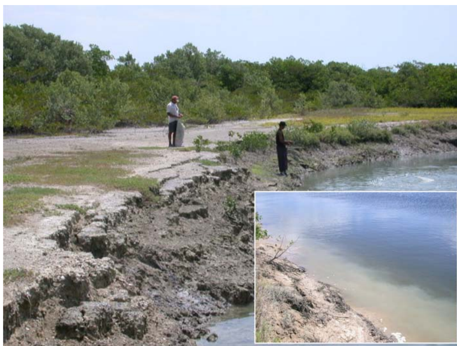
Figura 6.16. Erosão da planície de supramaré pela ação das marés de sizígia e das correntes de marés (margem esquerda do CD 1 em frente ao P4). O detalhe mostra a pluma de sedimentos em suspensão transportada tanto pelas correntes de vazante quanto de enchente.
