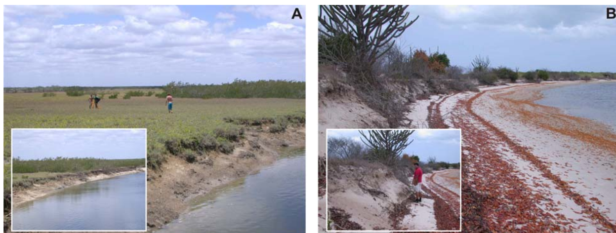
Figura 6.8. Sedimentos areno lamosos de supramaré com escarpa de erosão em frente ao P9 (A) e sedimentos arenosos eólicos fixos com escarpa de erosão em frente aos perfis P10 (B). As imagens em detalhe mostram a erosão nas margens dos canais com destruição do mangue (A) e da caatinga (B).
