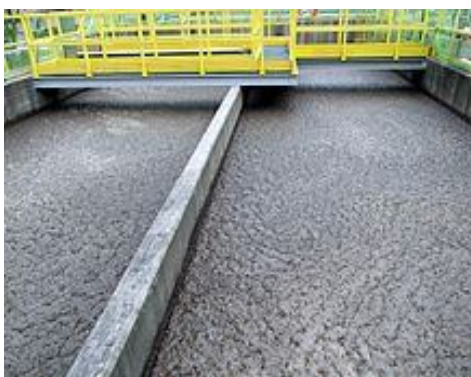
Figura 16 - Ar dissolvido sendo libertado em um tanque sob a forma de bolhas finas.
