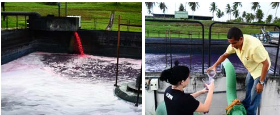
Figura 28 - Imagem do tanque de equalização do efluente no dia da coleta.
